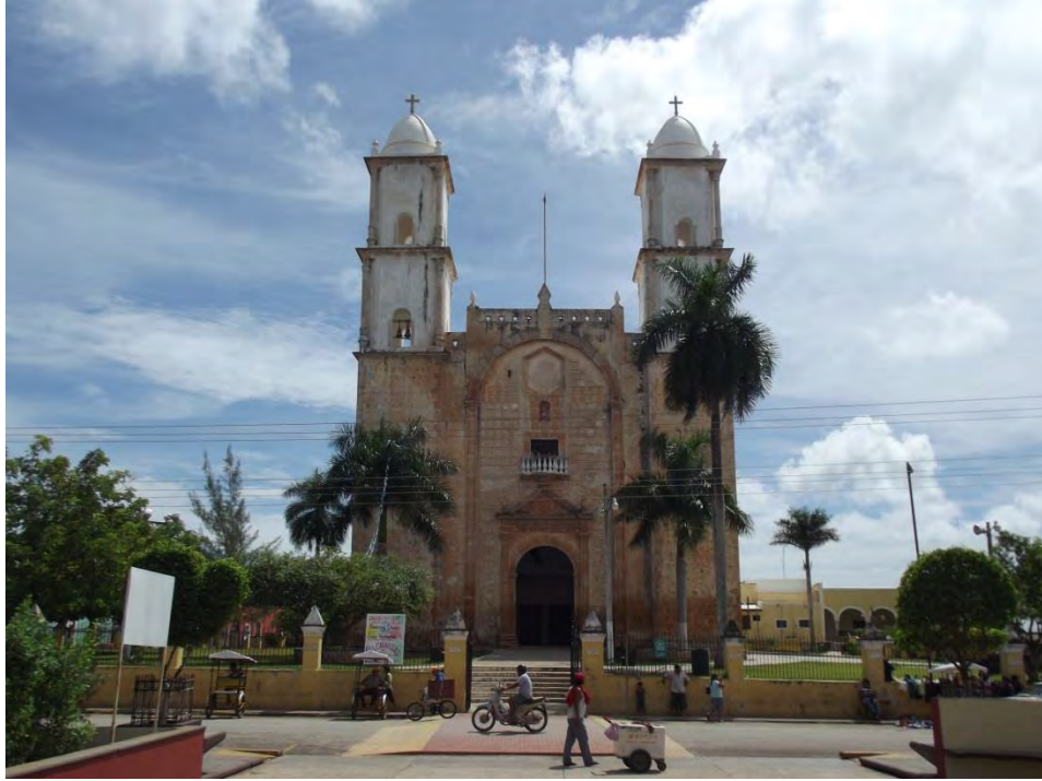
Ilustración 3: Iglesia Principal de la localidad de Peto
