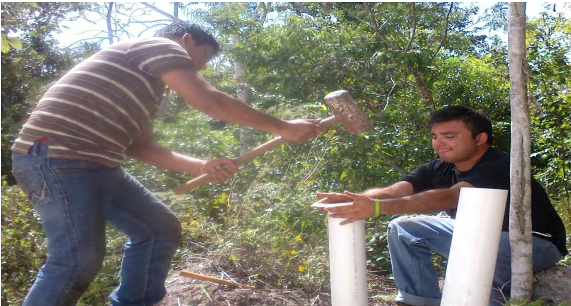
Imagen 2.1. Golpeando la placa para introducir el tubo.
