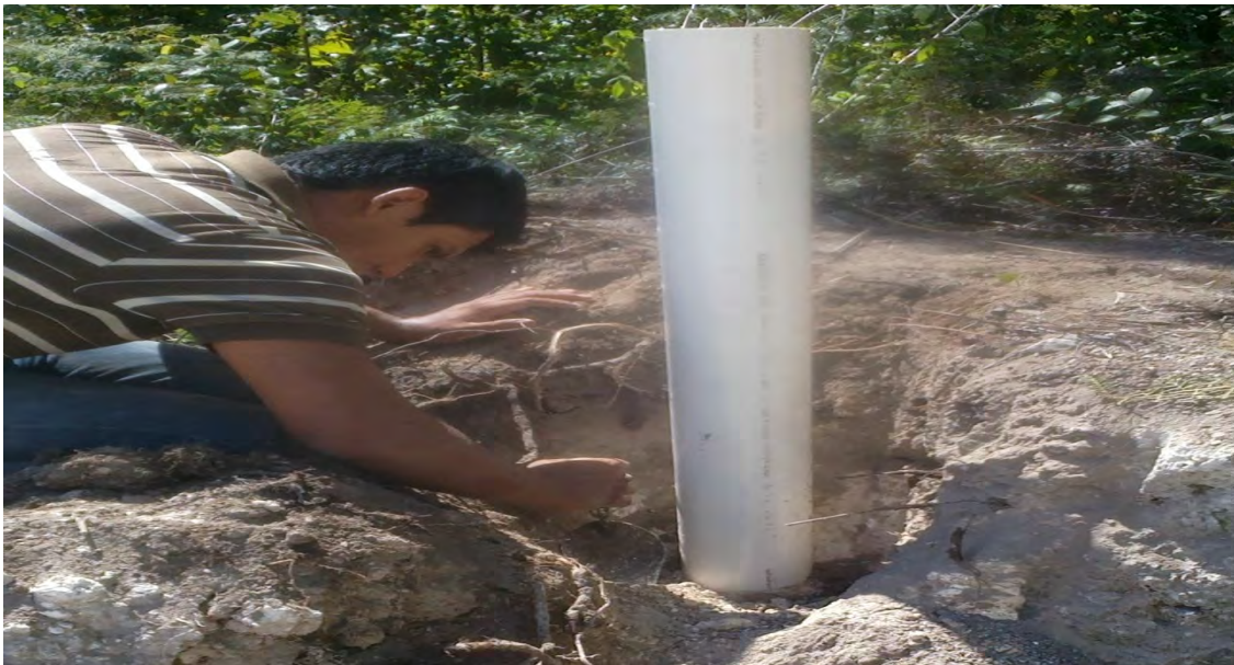
Imagen 2.1.1. Introducido a la profundidad deseada.
