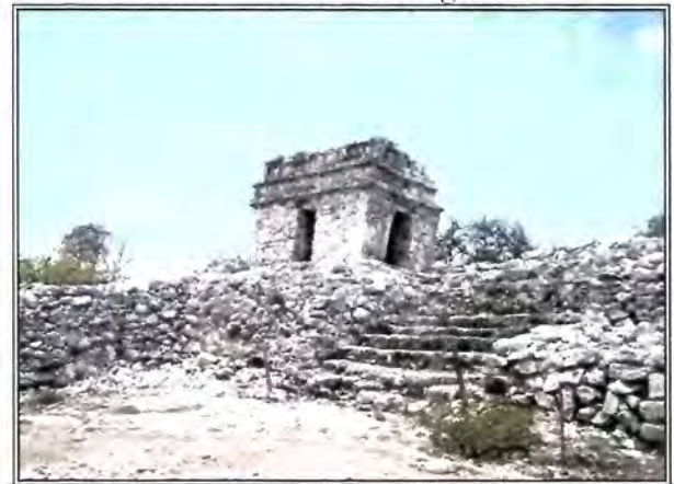
IMAGEN 7. Torre de vigilancia
