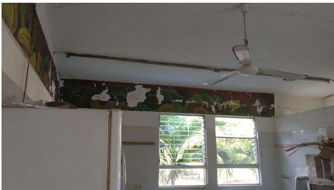
Foto 2, 3 y 4. Situación de la Casa Internacional del Escritor antes de su reapertura en febrero de 2017, 10/8/2016.
