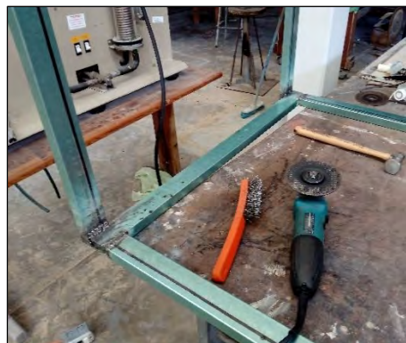
Figura III. 14. Construcción de la base de la cámara de secado solar de PTG.
