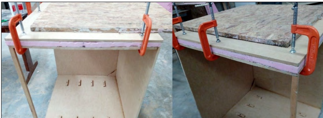
Figura III. 10. Aislamiento térmico de la cámara de secado.
