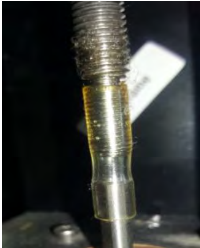
Figura 18: conexión husillo-rotor del actuador
