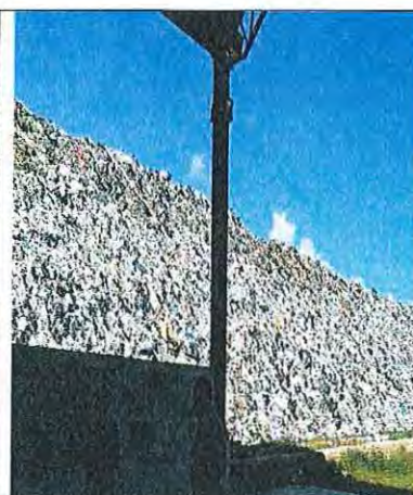
Imagen 3. No se detectó compactación ni cobertura para los RSU que son dispuestos.
