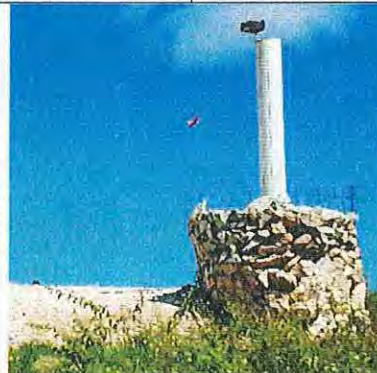
Imagen 4. Estructuras para la liberación del biogás.
