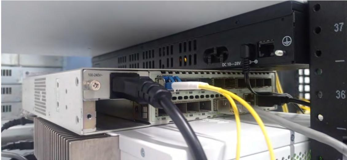
*Ilustración 33 Demarcador Raisecom instalado en NOC/site principal*
