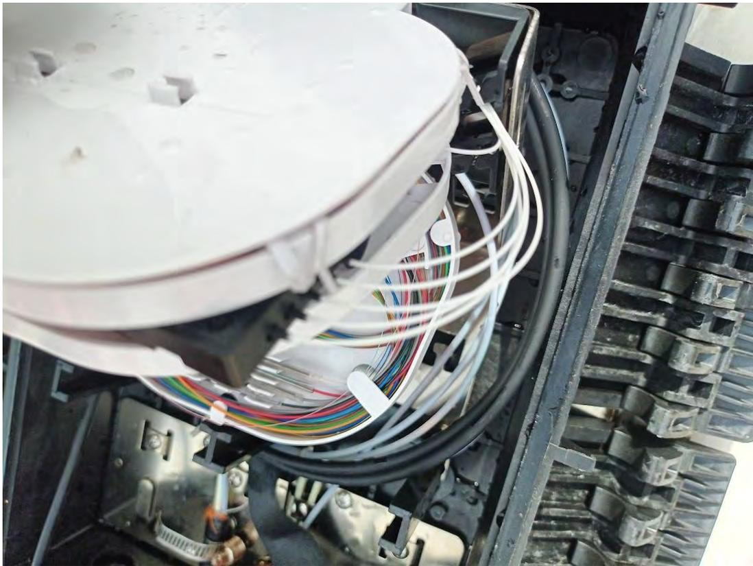
*Ilustración 45 DEMUX colocado en caja de derivación*
