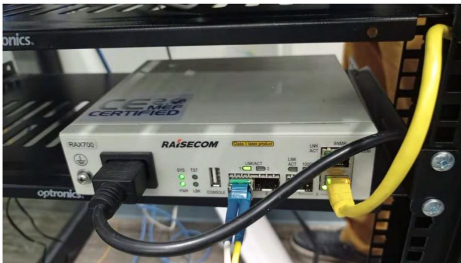
*Ilustración 32 Demarcador Raisecom instalado en rack de oficinas*
