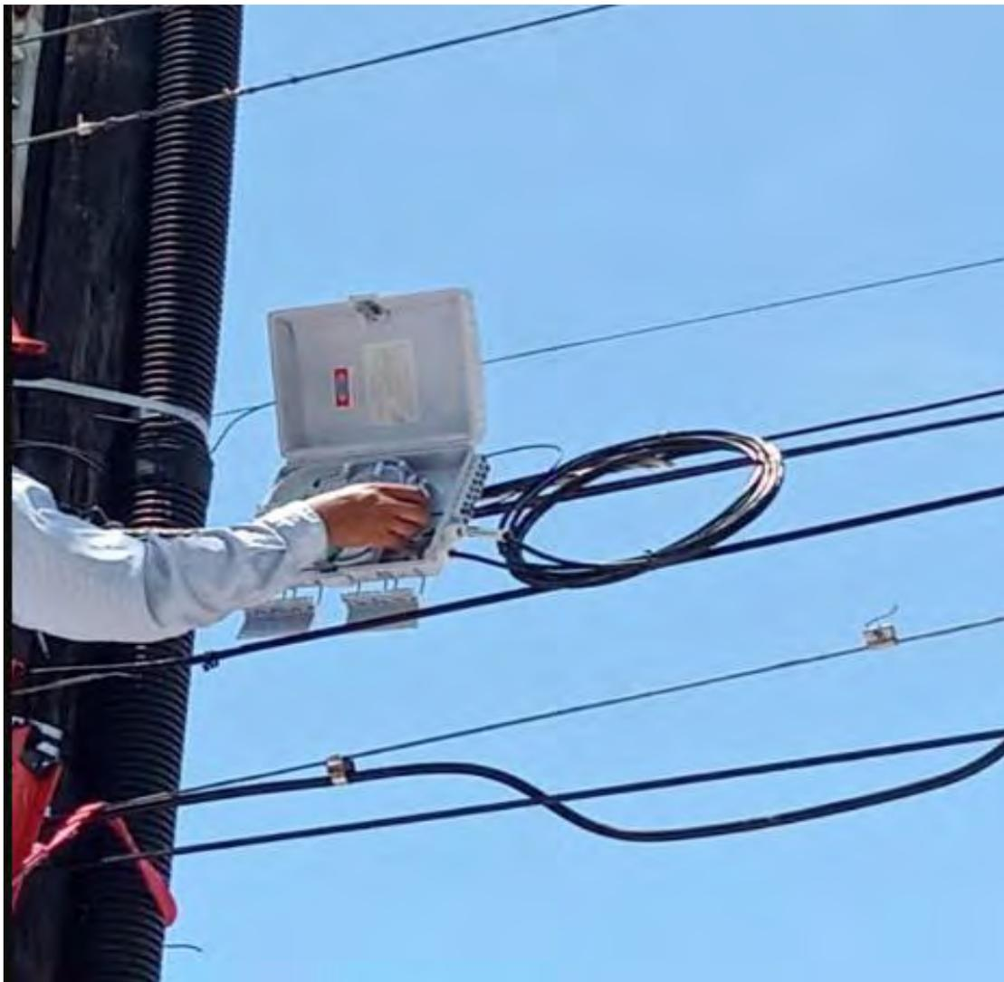
*Ilustración 42 Colocación de cajas de empalme*
