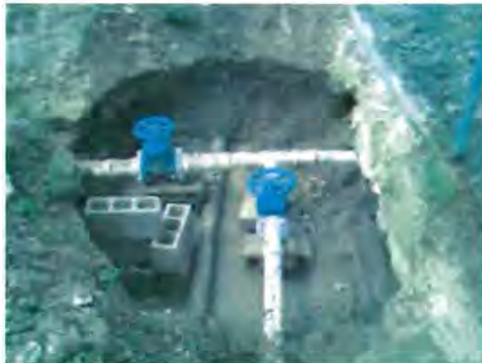
Fotografía No. 9 Instalación de válvulas y piezas especiales.
