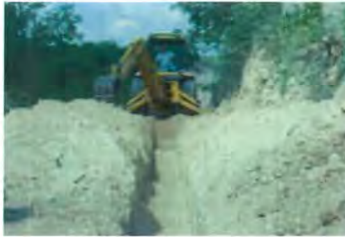
Fotografía No. 3 Máquina retroexcavadora realizando limpieza de zanjas.
