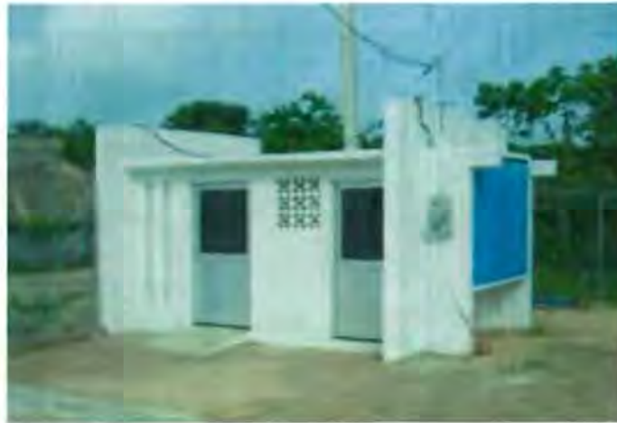
Fotografía No. 11 Caseta de cloración de Naranjal.
