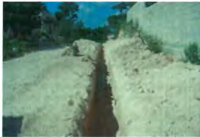
Fotografía no. 4 Zanja terminada lista para recibir plantilla.
