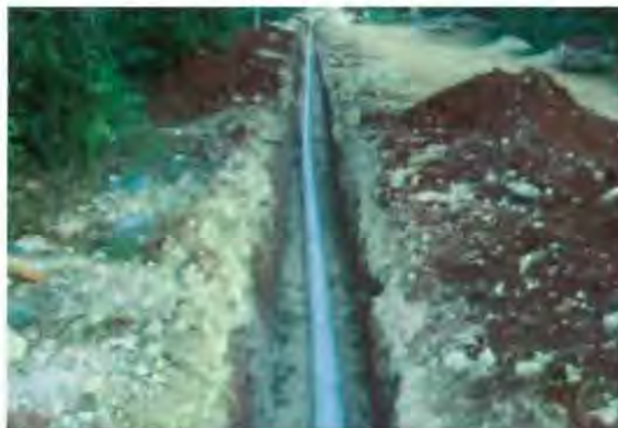
Fotografía No. 8 Tubería instalada.
