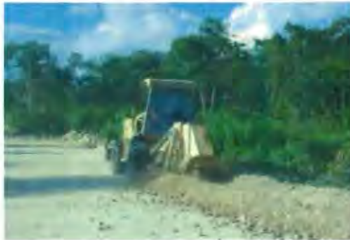
Fotografía No. 2 Máquina zanjadora realizando excavación de zanjas.
