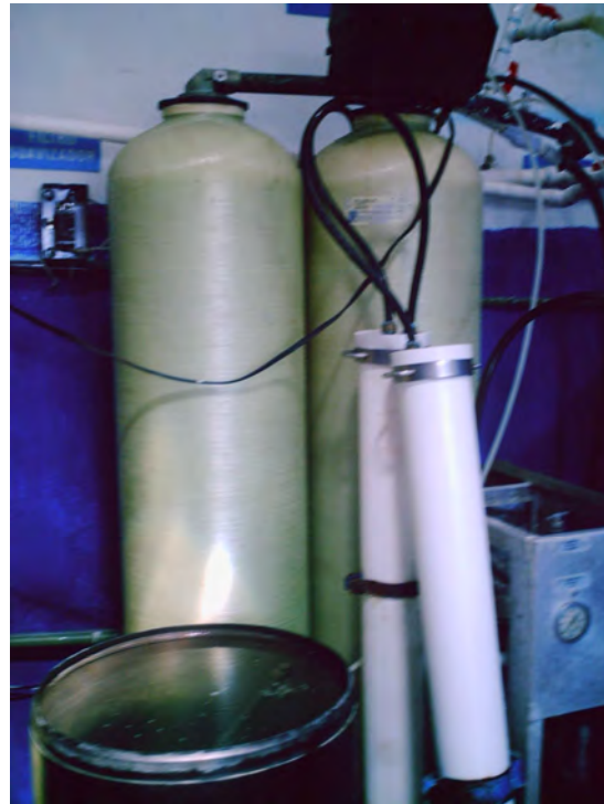
Fig. 18. Filtro con resinas de intercambio iónico
