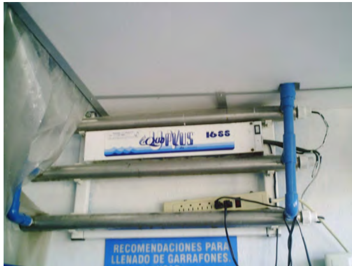
Fig. 20. Equipo de Radiación Ultravioleta
