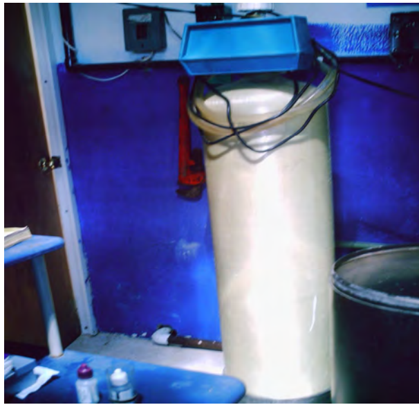
Fig. 16. Filtro de arenas sílicas con un volumen de 3 pies cúbicos. Planta Purificadora San Antonio.
