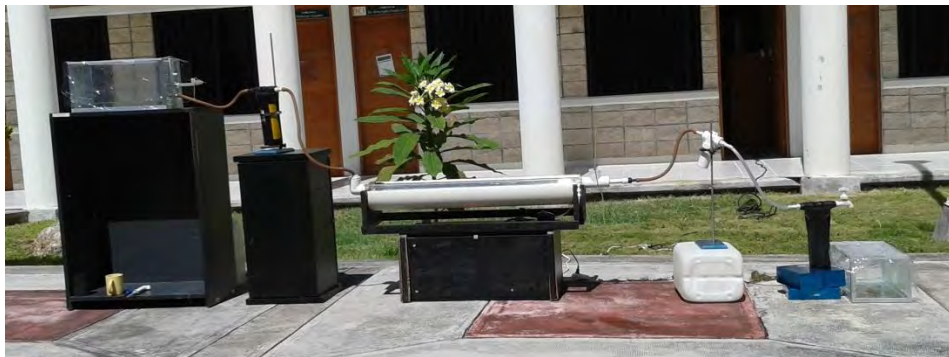
Figura 13. Proceso de tratamiento de agua de lluvia, con un reactor de proceso de oxidación avanzada.
