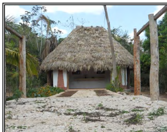
Figura 14. Futura palapa de servicios de la empresa Native Choice, Chacchoben. Fuente: Propia.
