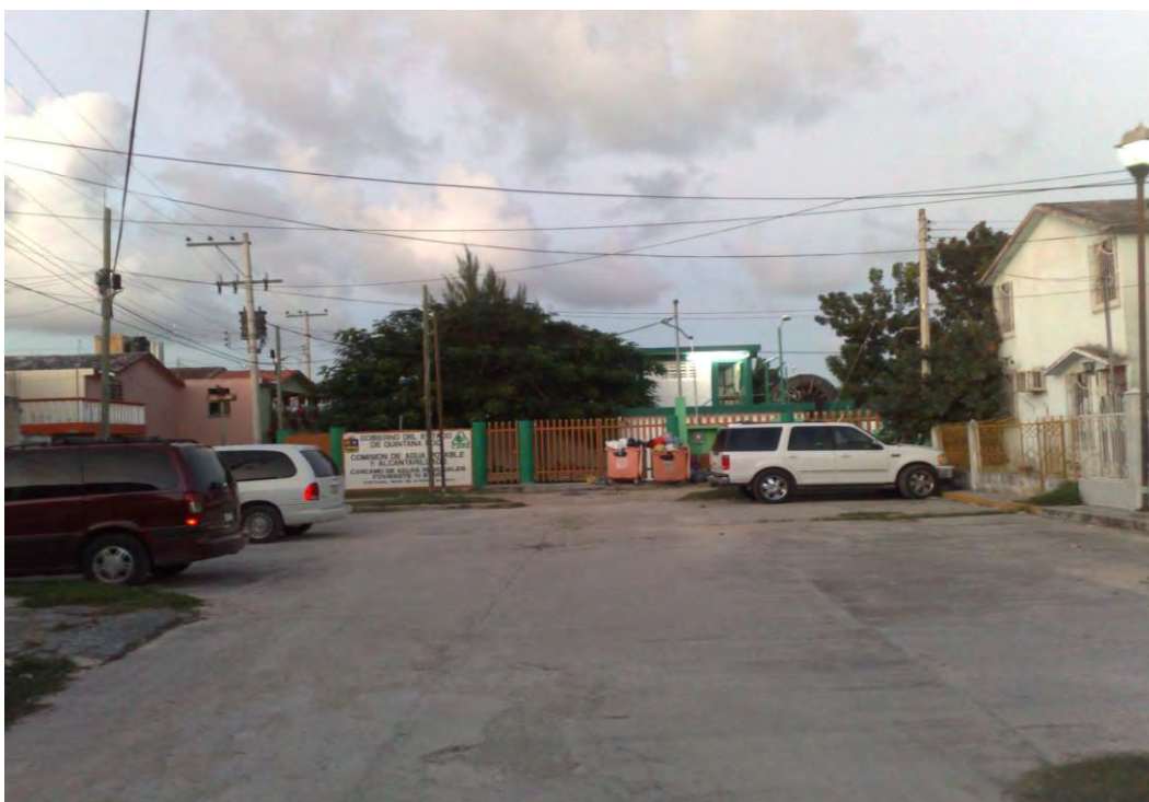
Fot. 4 Carcamo de rebombeo en las inmediaciones de la colonia.
