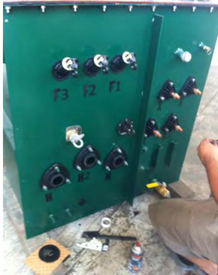
**Figura 29.** Pintura y rotulación de un transformador.
