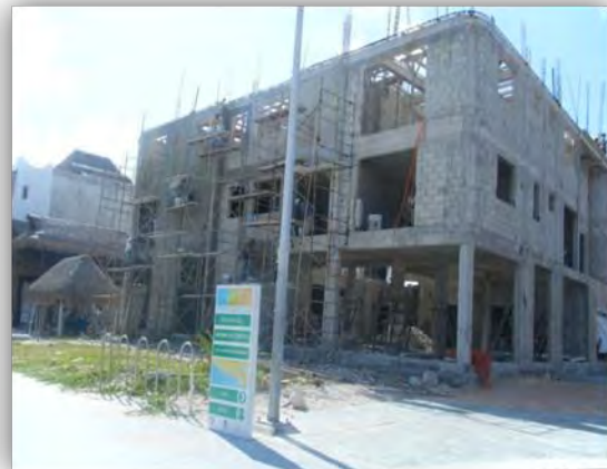
Foto 21. Construcción de hotel Fuente: Propio autor
