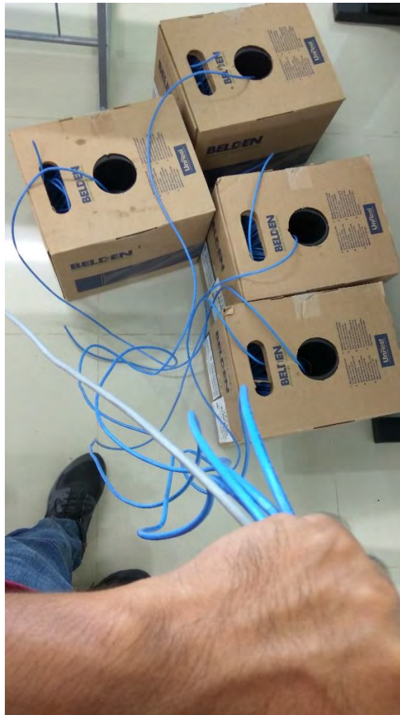
Figura 20 Proceso de instalación de cableado Fuente: Elaboración Propia
