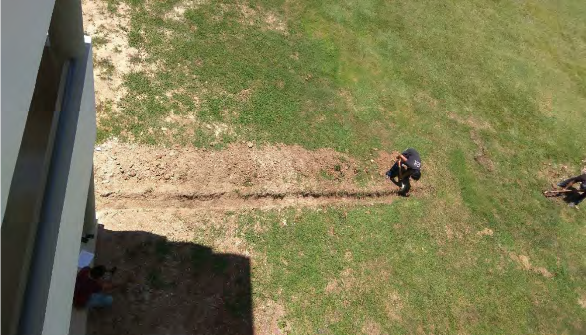
Figura 19 Preparación del área de los ductos subterráneos Fuente: Elaboración Propia
