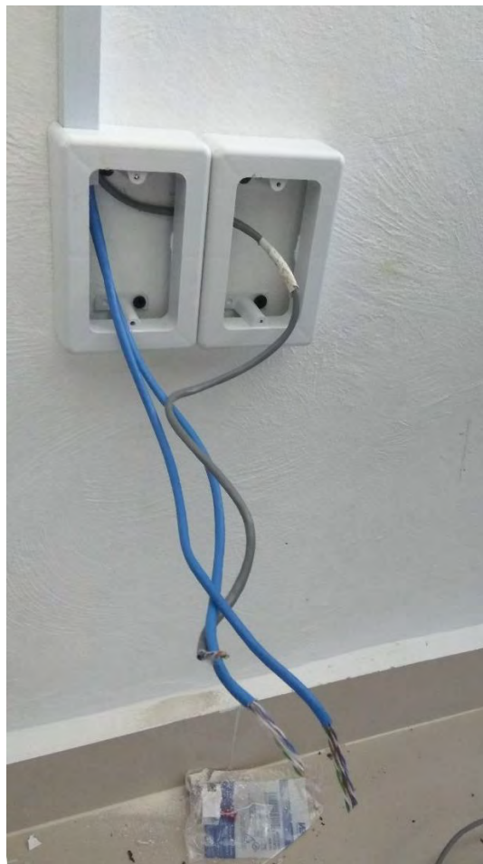
Figura 21 Nodo de voz y datos en proceso de instalación Fuente: Elaboración Propia
