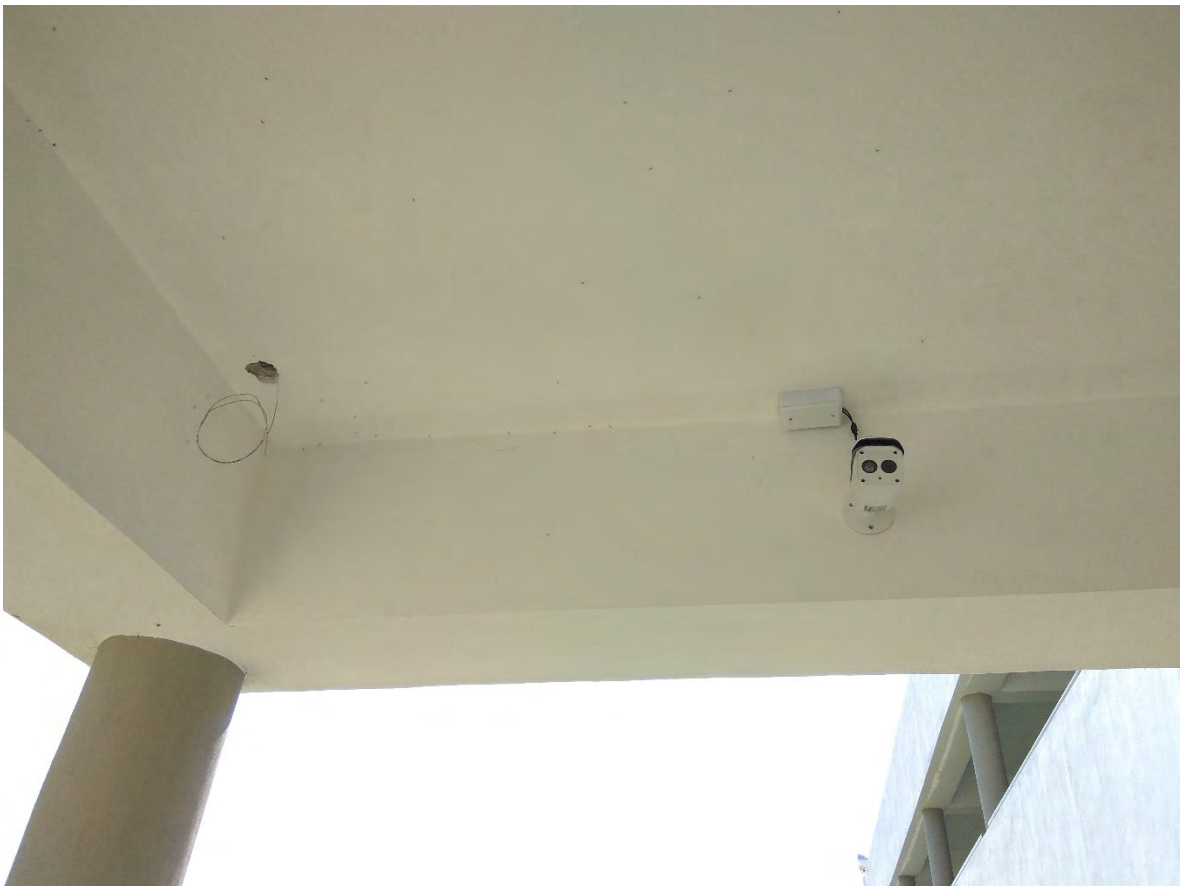
Figura 10 Fijación de cámara tipo bala Fuente: Elaboración Propia
