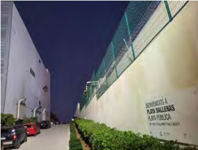
Figura 7. Acceso público a Playa Ballenas. Para poder llegar hasta la playa, las personas deben caminar a un lado de los ductos de las cocinas y lavanderías de un hotel que fue construido justamente a un costado del acceso. Fuente: Elaboración propia.
