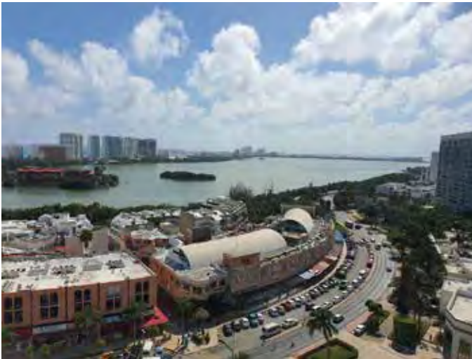
Figura 6. Punta Cancún. Se puede observar la alta densidad de infraestructura que existe para el poco espacio que existe entre la Laguna Nichupté y la línea donde comienzan los hoteles. Fuente: Elaboración propia.
