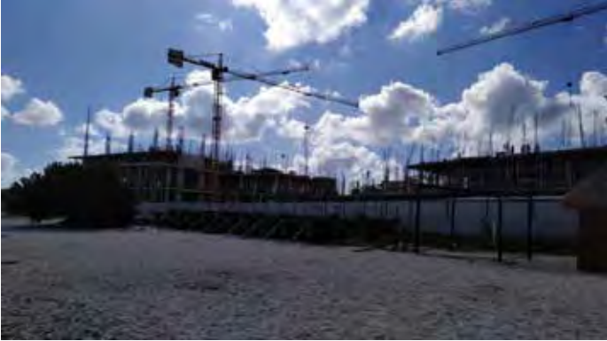
Figura 3. Construcción de hotel en una de las playas más visitadas por locales y turistas, por lo que ha generado varias quejas ciudadanas. Fuente: Elaboración propia.
