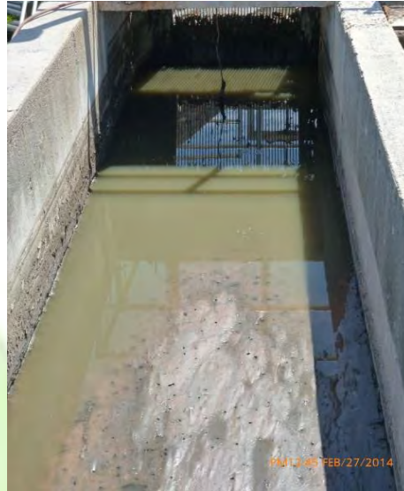
Figs. 3.2 y 3.3.- Entrada de las aguas residuales y ausencia de caudal en el Desarenador, respectivamente.
