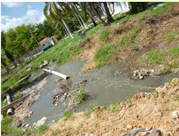
Figs. 3.4 y 3.5.- Desvío de las aguas residuales sin el previo tratamiento a la sabana y la falta de recirculación de los lodos en el Pretratamiento, respectivamente.
