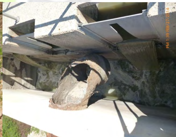
Figs. 3.4 y 3.5.- Desvío de las aguas residuales sin el previo tratamiento a la sabana y la falta de recirculación de los lodos en el Pretratamiento, respectivamente.
