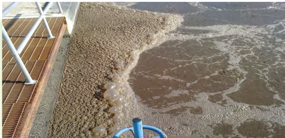
Fig. 3.16.- Formación de Espuma en el Reactor Biológico.
