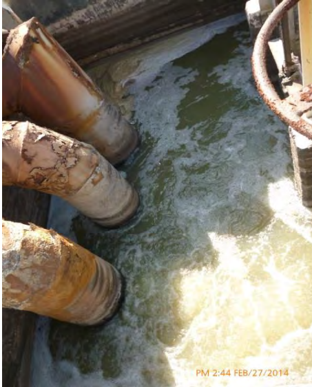
Figs. 3.2 y 3.3.- Entrada de las aguas residuales y ausencia de caudal en el Desarenador, respectivamente.
