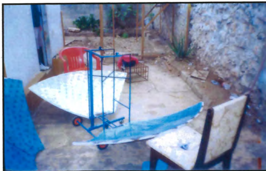
Fig. 13 y 14. Estructura metálica del dispositivo solar e instalación de la superficie reflejante
