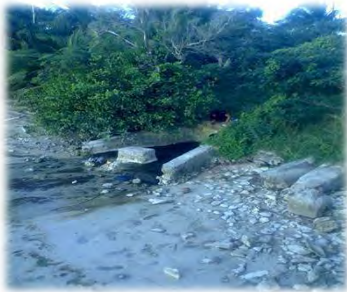
Figura 3.3.- Descarga ubicada a un costado de la Mega escultura (punto B).
