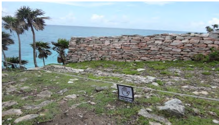
Fuente: La muralla de Tulum , lado Sur, fotografía de Genny Gutiérrez Dzul, 2014
