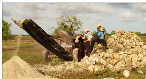
Hijos ayudando al papá quebrando piedras para hacer polvo y grava para la casa nueva.
