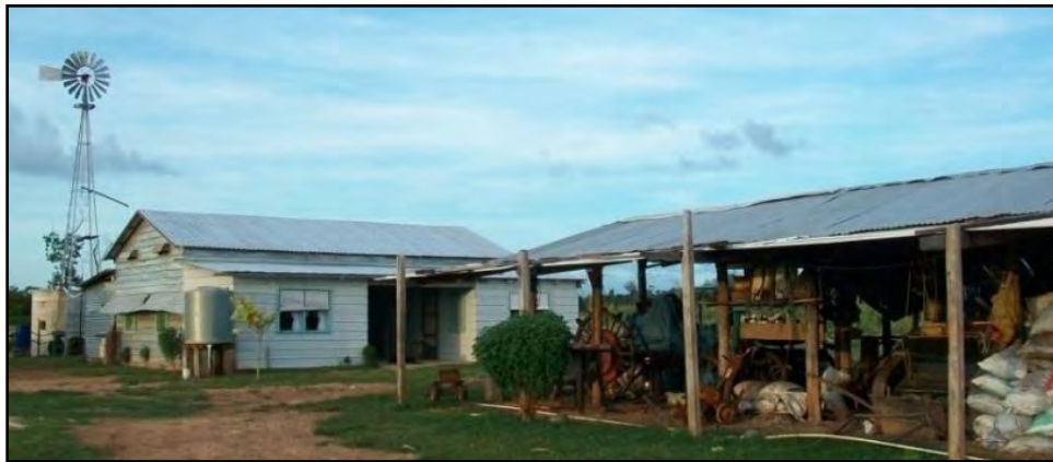
Fotografía de la casa antes de la tormenta tropical Karl. El tinglado que está en frente de la casa, fue la primera vivienda de la familia, pero después del huracán Dean paso a ser utilizada como bodega, taller y porqueriza, la que después derrumbara la tormenta tropical Karl.
