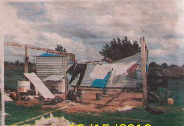
Dieses Haus ist ganz zerstört. Bleibplatten wurden vom Sturm abgerissen, und nur ein Teil der Wände blieb an der Stelle, wo das Haus stand.
