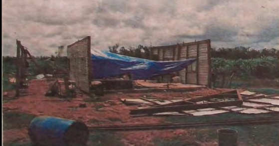
Zwei Wände blieben stehen, welche benutzt werden, um eine Plane zu halten, welche zeitweilig als Dach dient.
