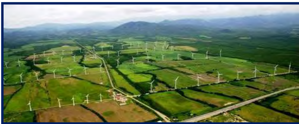
FIGURA 5 VISTA AÉREA DEL PARQUE EÓLICO LA VENTA II (CFE, 2012)
