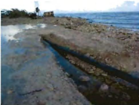
**Foto 1.** Líneas de conducción de aguas residuales, completamente expuestas.
