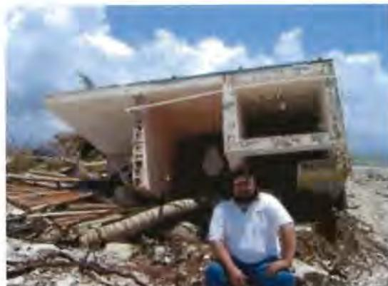
**Foto 8.** Mi persona sentado en el costado de un Baño a base de block y concreto completamente levantado desde sus cimientos, el cual formaba parte de un restaurante ubicado a unos 30 m aprox. de la línea de costa.
