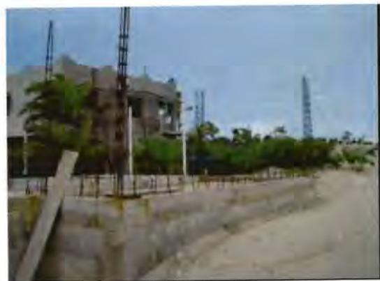
**Foto 15.** Cimentación de una casa habitación con su muro de enrase por arriba de la altura de la duna costera.
