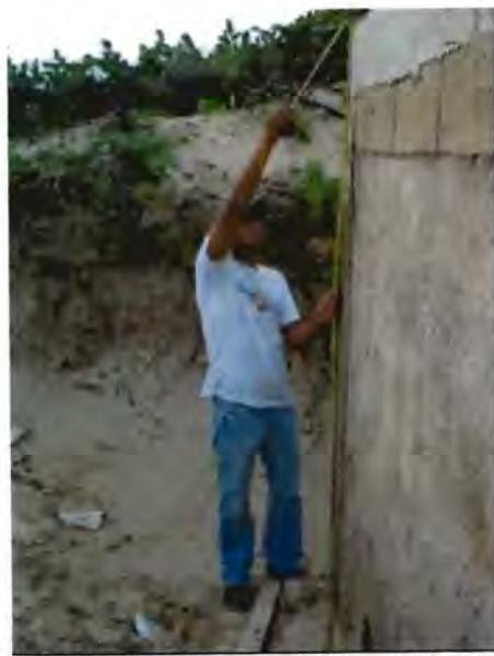
**Foto. 14.** Profundidad de la Zapata Corrida en la construcción de una casa habitación en la Costa Maya.
