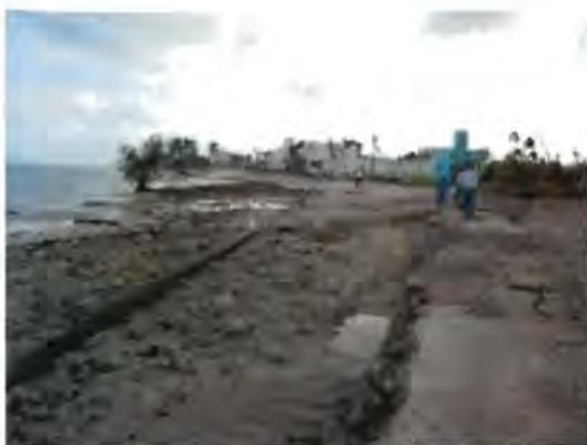
**Foto 7.** Camino costero parcialmente destruido y zona de playa "lavada", se puede apreciar las líneas de conducción de aguas residuales completamente expuestas, un "escalón" a lo largo del camino y la inexistencia de arena.
