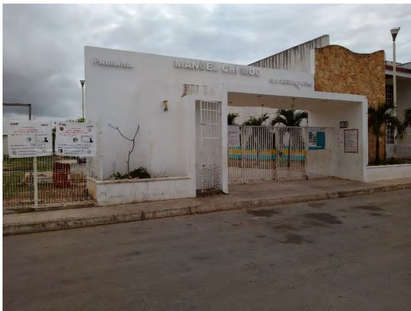
Fuente: Barradas, Franco. Trabajo de campo.
