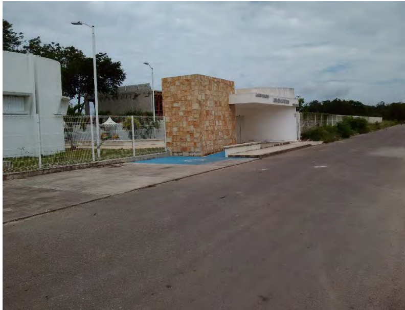
Imagen No. 9 Jardín de niños Armada de México en la sección III del fraccionamiento Las Américas.
