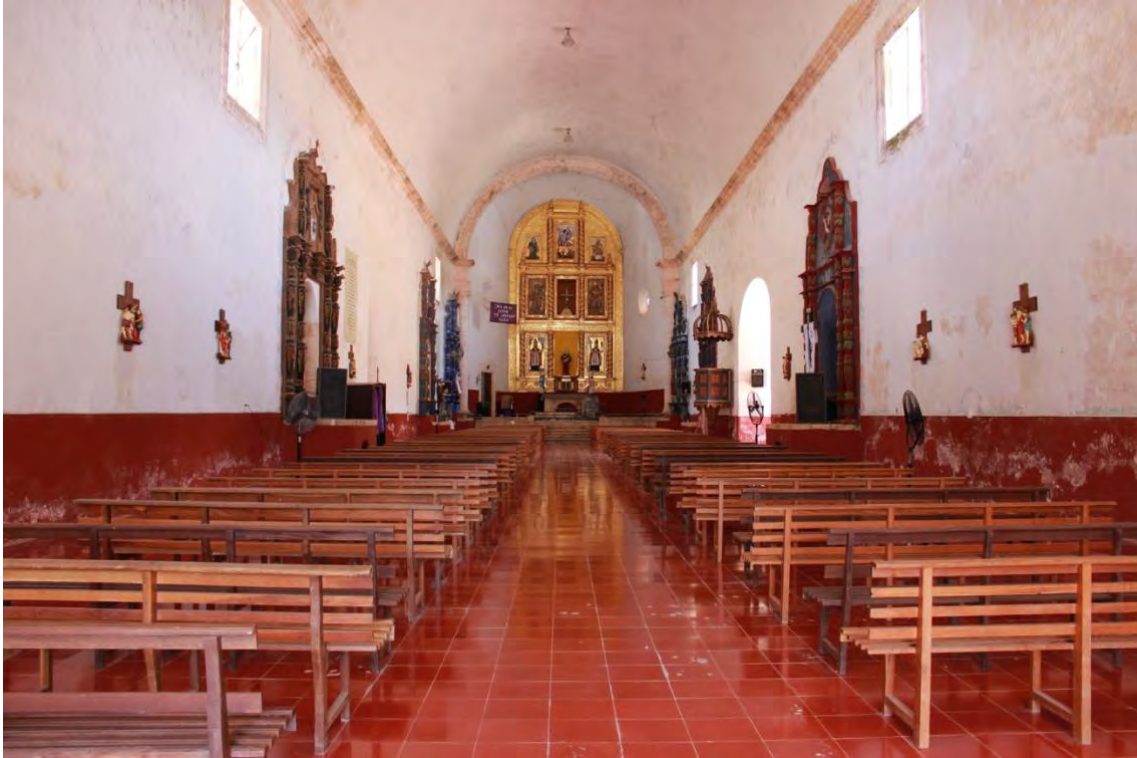
Interior de la iglesia, Yaxcabá.
