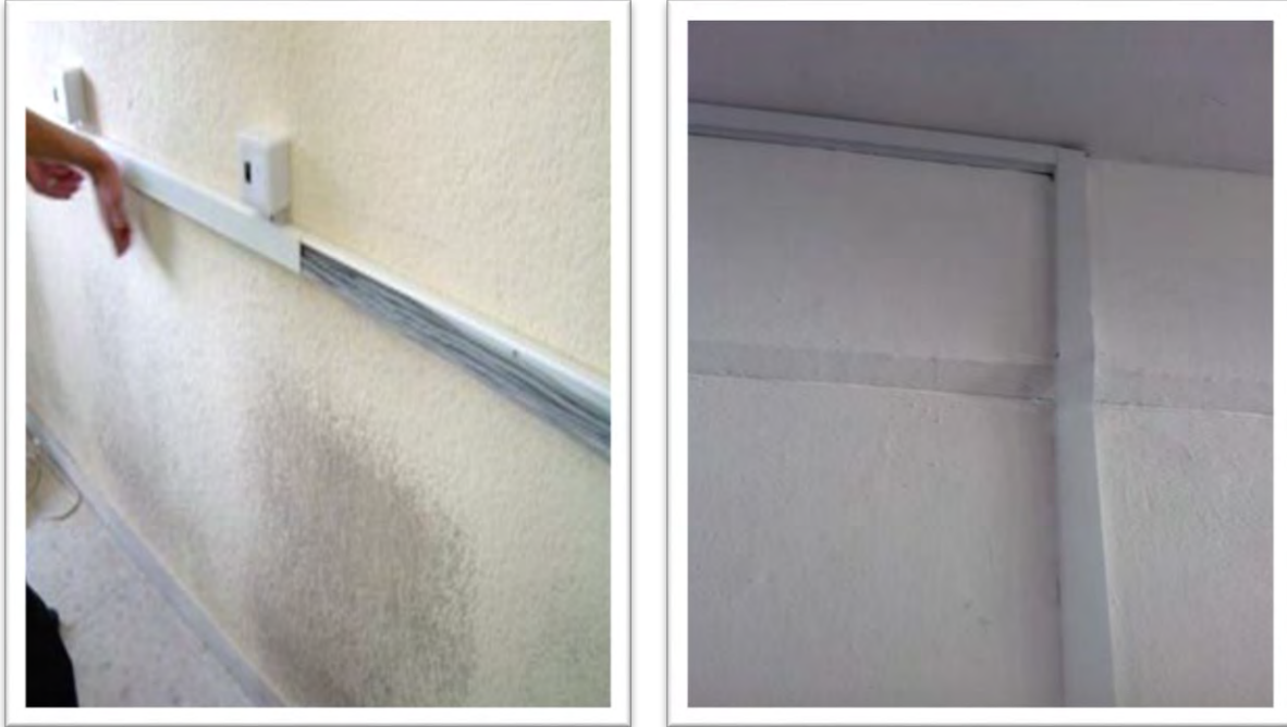
Figura 8 Instalación de canaletas
