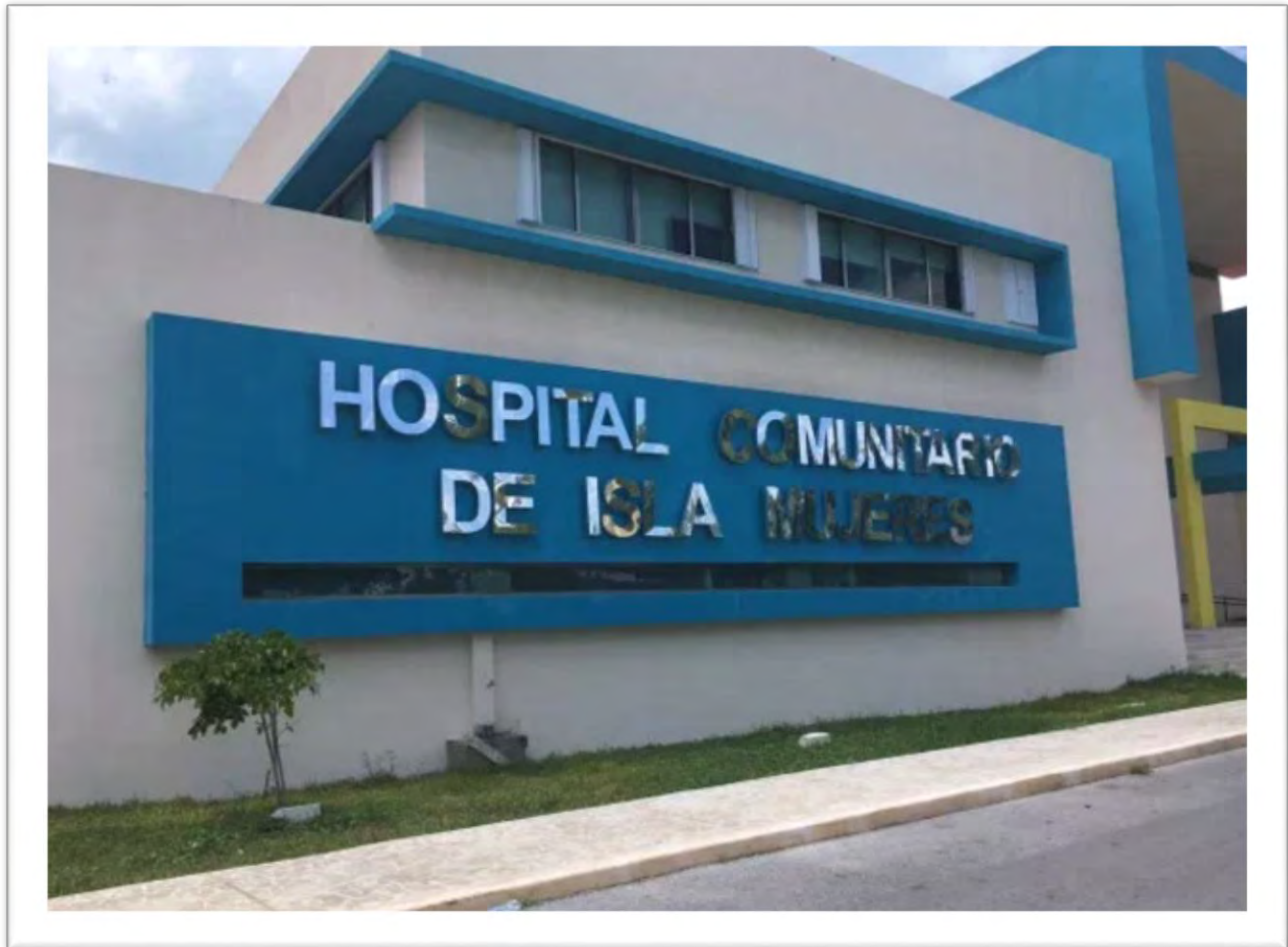
Figura 16 Edificio que ocupa el Hospital Comunitario de Isla Mujeres
