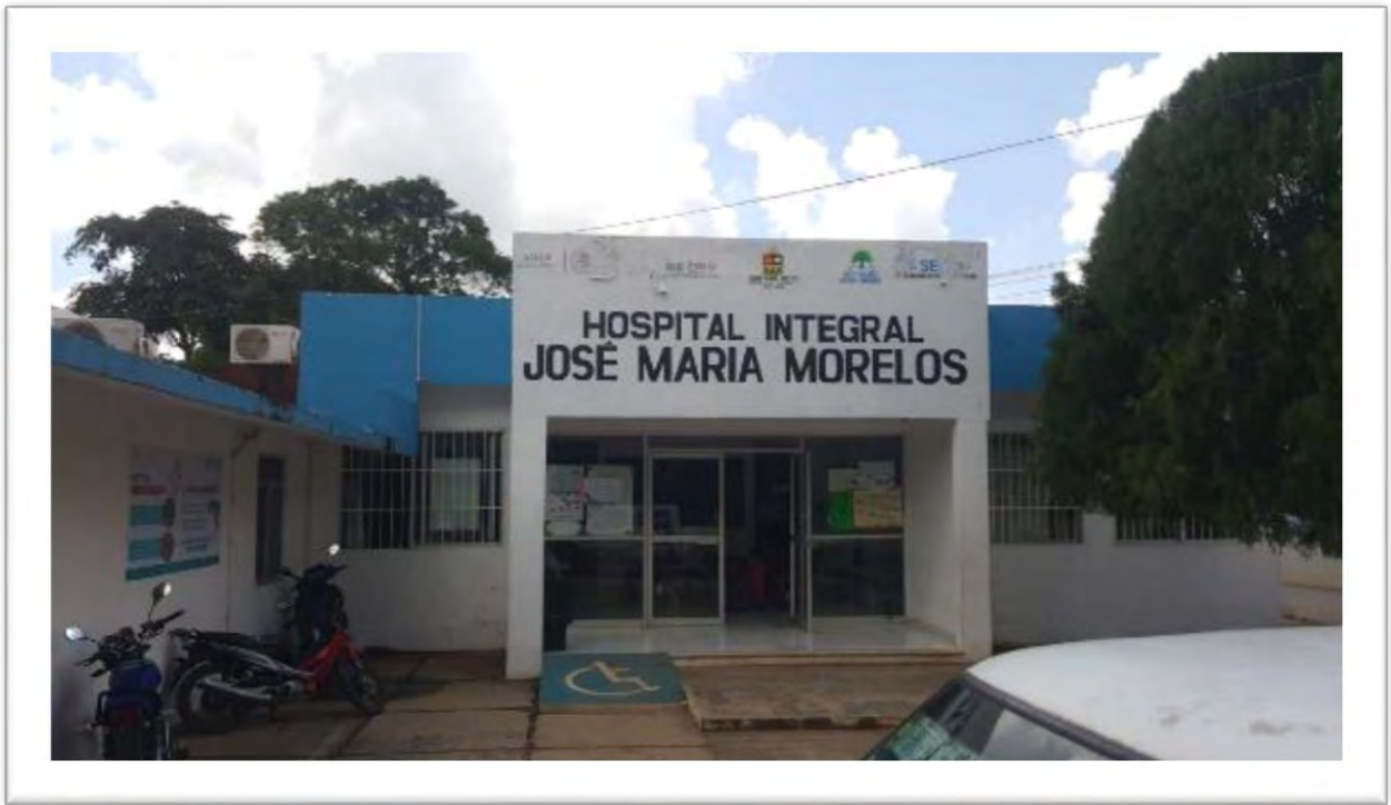
Figura 8 Edificio que ocupa el Hospital Integral de José María Morelos
