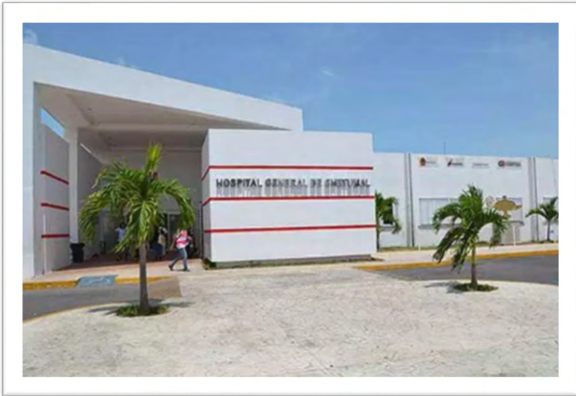
Figura 27 Edificio que ocupa el Hospital General de Chetumal
