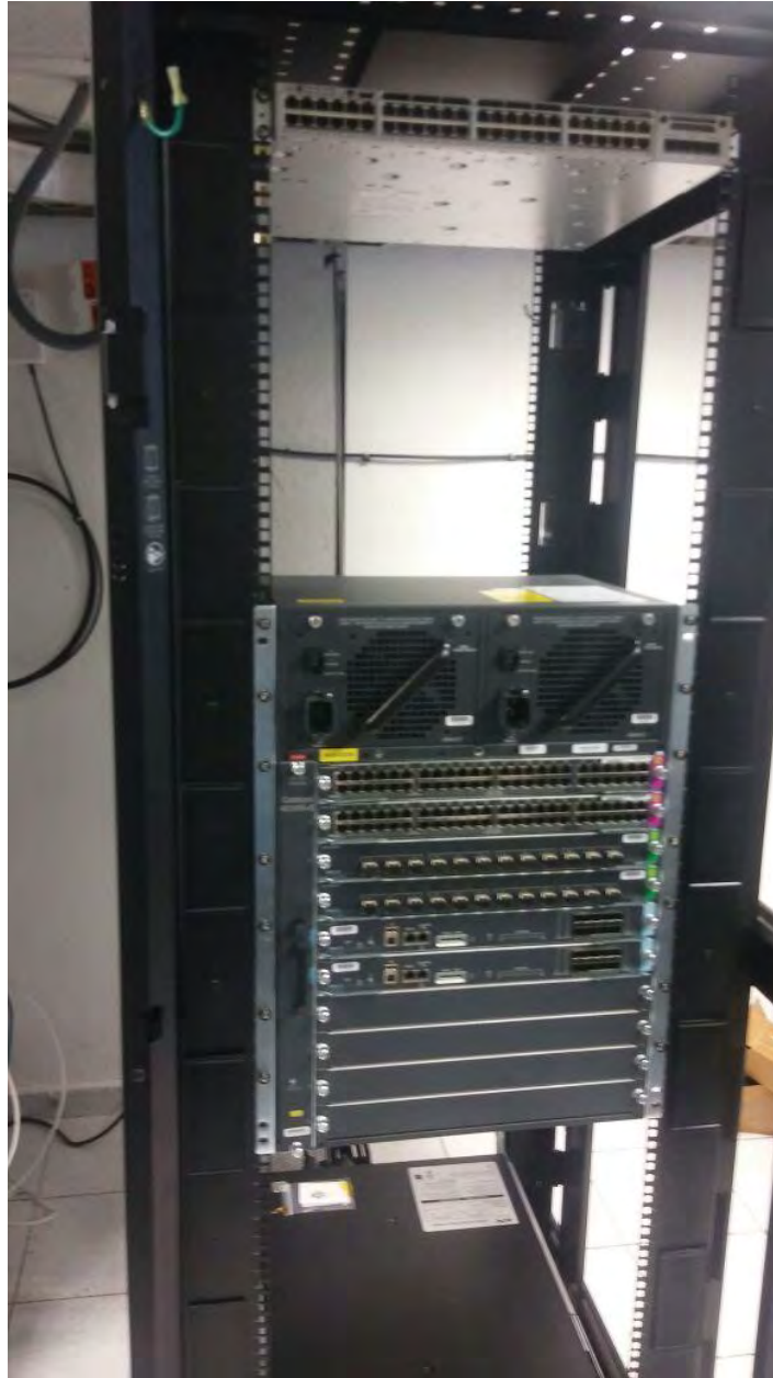
Figura 4-15. Montaje de Cisco Core en rack
