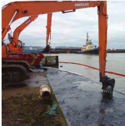
Figura 8. Recolección mecánica de hidrocarburos (ITOPF, 2011a)
