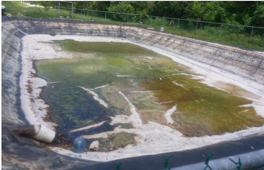
Figura 3.1 Los lixiviados utilizados para las pruebas de biosorción se tomaron del tubo de colección en la laguna de lixiviados del relleno sanitario del Municipio de Bacalar.
