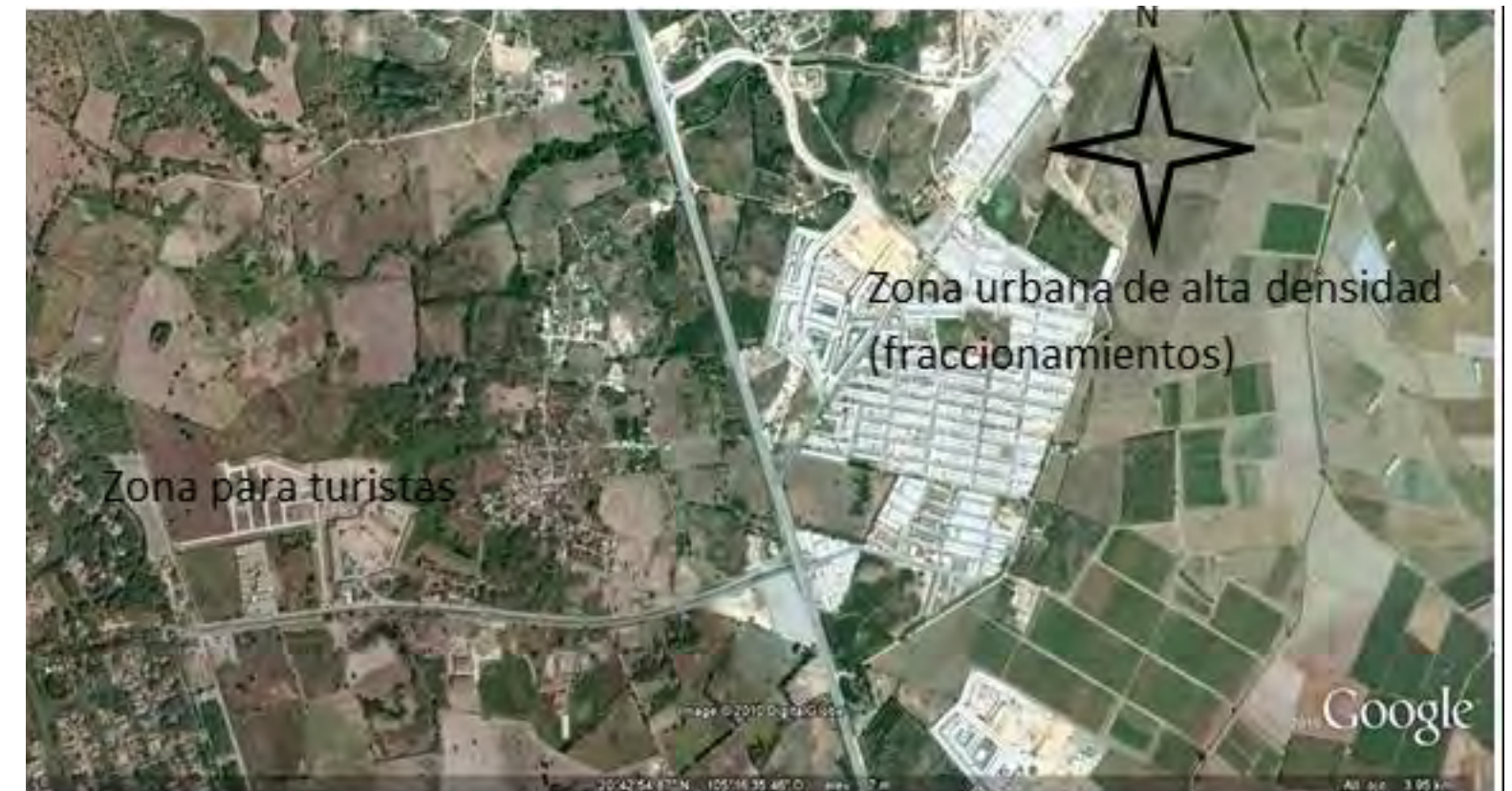
Fig. 3. Fraccionamientos asentados a la margen poniente de la carretera federal 200. La autopista divide la zona turística y la zona urbana de alta densidad. Nuevo Vallarta, Municipio de Bahía de Banderas, Nayarit.
