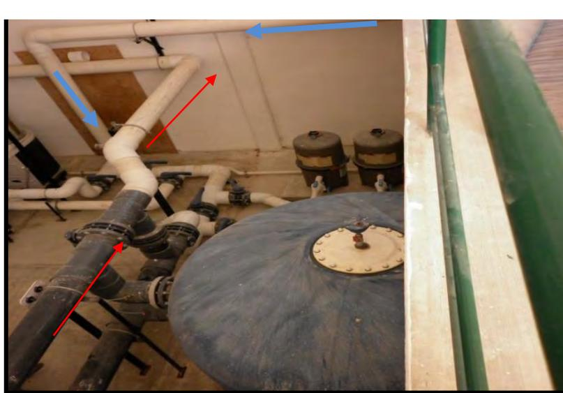
Figura 12.- Diagrama de flujo del agua que hace en el sistema de bombeo muestra la conexión de los filtros de arena, al fondo los más pequeños y de color negro son los filtros de carbón activado, las flechas azules van hacia los calentadores eléctricos.[26]
