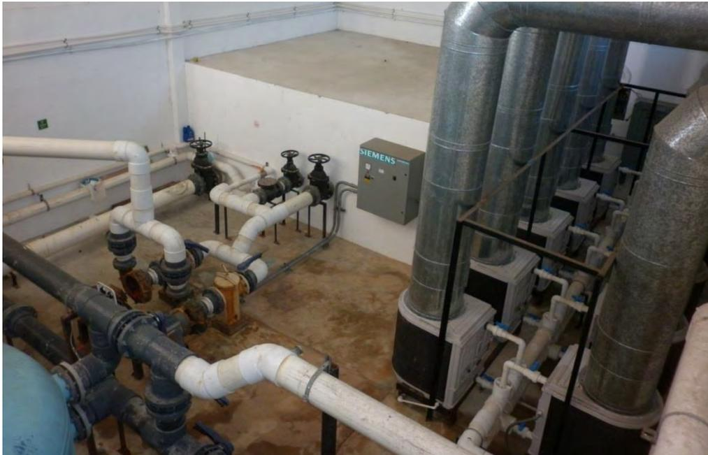
*Figura 22.- Vista del lado derecho las conexiones de los calentadores eléctricos, al fondo del lado izquierdo la caja de regulación de agua y las bombas de agua. Fuente propia*
