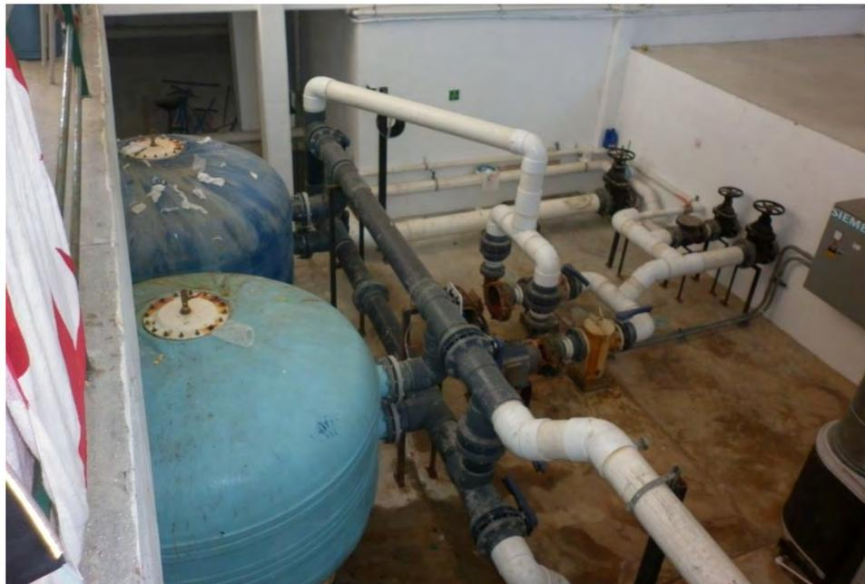
*Figura 23.- Vista del ángulo del lado izq. Los filtros de arena así como las conexiones que vienen de las bombas, al fondo la caja de regulación. Fuente propia*
