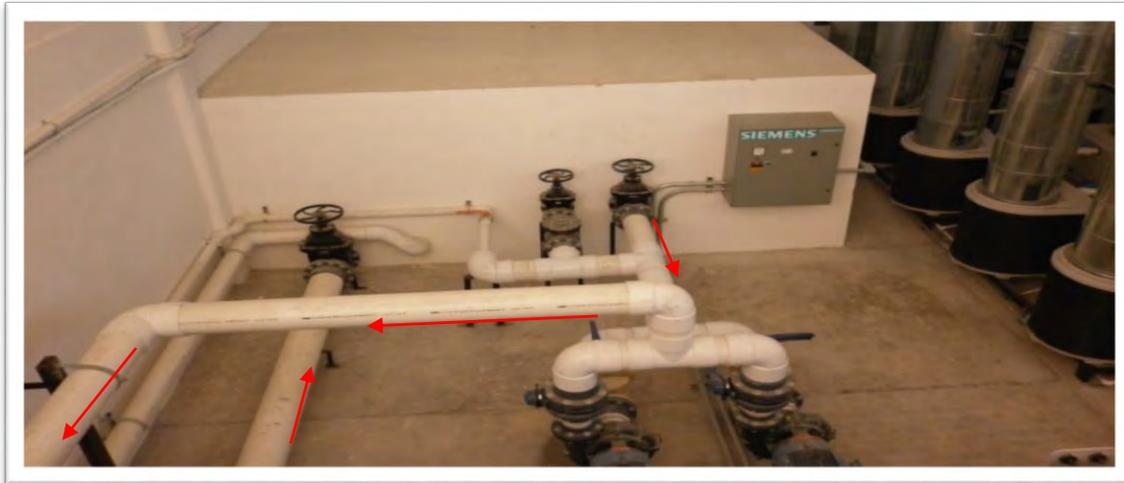
Figura 10.- Diagrama de flujo del recorrido del agua en la tubería de llegada al vaso regulador. Es el tanque cuadrado al fondo. [24]
