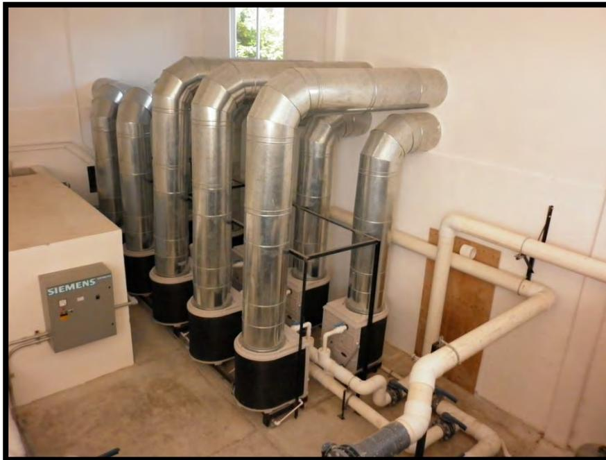
*Figura 14.- Sistema de conexión de los calentadores eléctricos (Heat siphon). Estos equipos funcionan con electricidad y son los que calientan el agua cuando de hace recircular a través de un serpentín de acero inoxidable y regresan a la fosa a una temperatura de 57° C. [28]*
