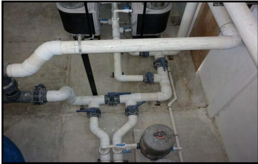
*Figura 13.- Muestra el bypass de la línea que viene de los filtros de arena hacia los filtros de carbón activado y también la línea que va hacia los 10 calentadores eléctricos donde se reduce la tubería de 8" a dos líneas de 4", posteriormente se vuelve a reducir de 4" a 1" para cada entrada de los calentadores eléctricos Heat siphon. [27]*
