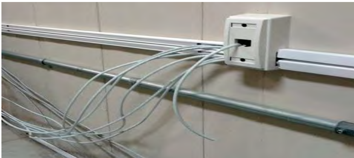
Figura 10. Roseta donde se conectará el cable de red con la computadora final.
