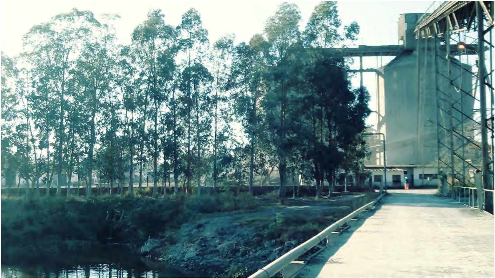
Imagen 4. Cortina forestal y tubería que desagua al río.
