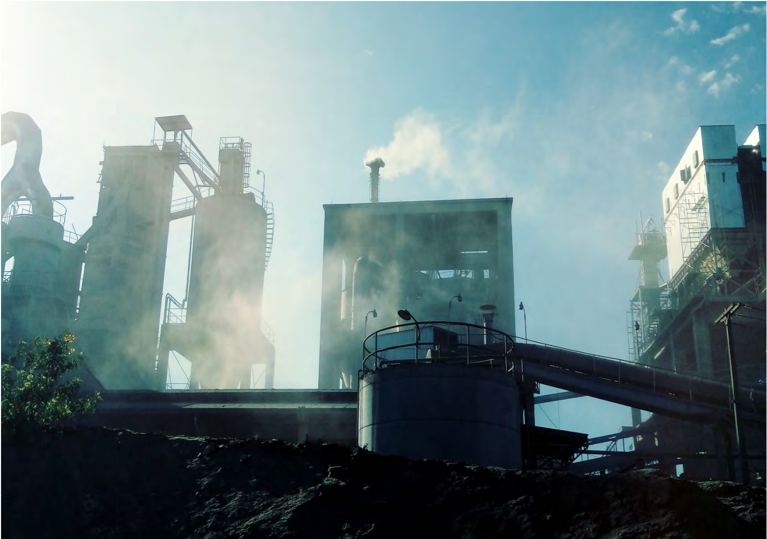
Imagen 1. Interior de la INC, máquinas emanando polvo y gases.
