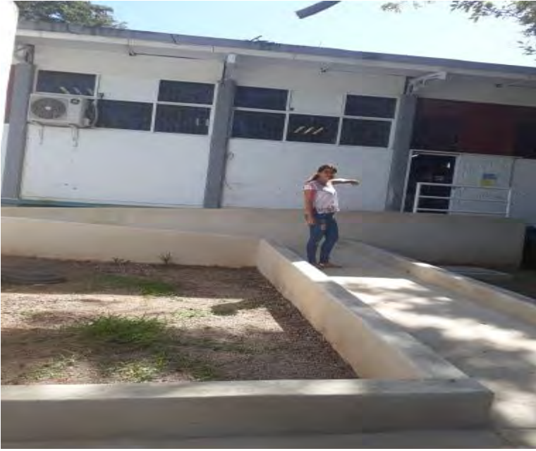
Imagen 43. Rampa hacia el archivero.
