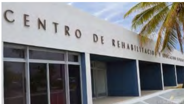
Imagen 19. Centro de Rehabilitación. (Tomada de: http://elinformantebcs.mx/wp-content/uploads/2016/04/elinformantebcs.mx_cree-750x500.jpg ).
