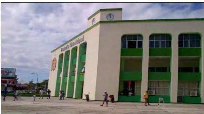
Imagen 24. Edificio del Municipio Othón P. Blanco.
