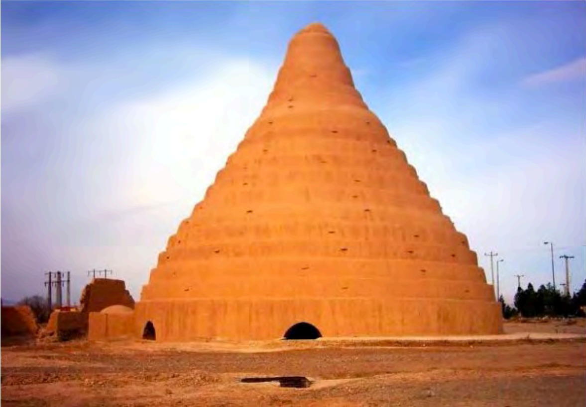
Figura 1.7. Frigorífico natural denominado “Yakhchal” o pozo de hielo. Fuente: Ramírez (2015).
