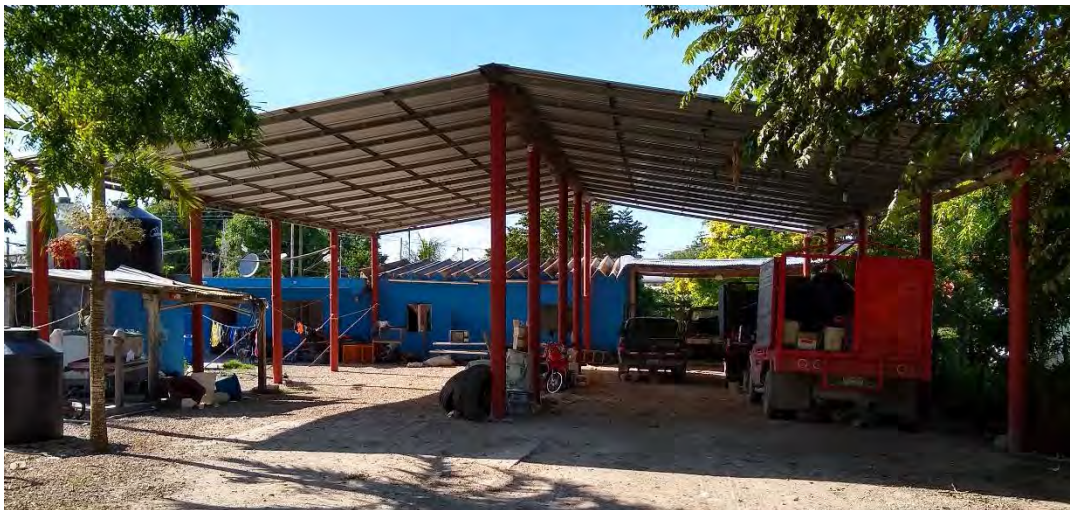
Figura 4.7 Estructura de techado tipo domo.
