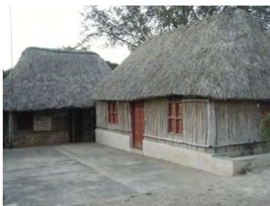
Figura 14. Bodega. Fuente: Propia, 2008.
