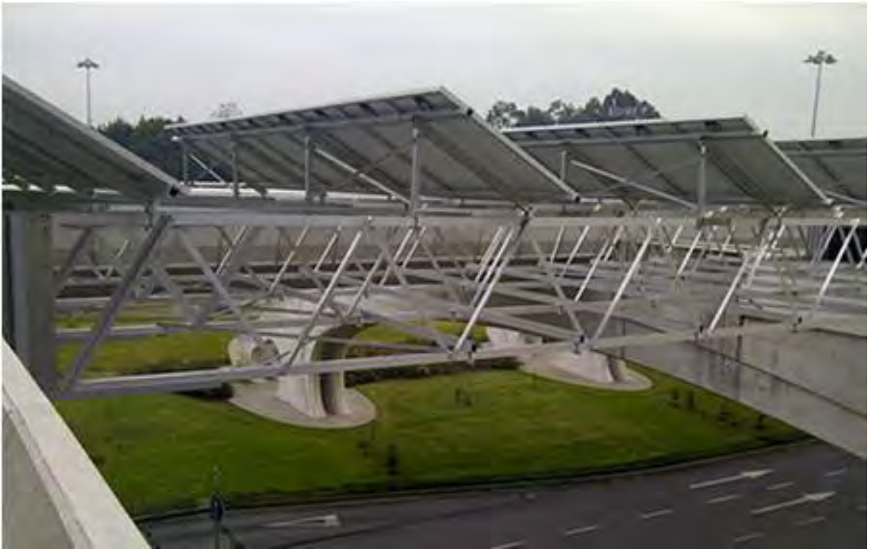
Figura 21: Fotografía de una estructura de soporte (Anon., 2014).
