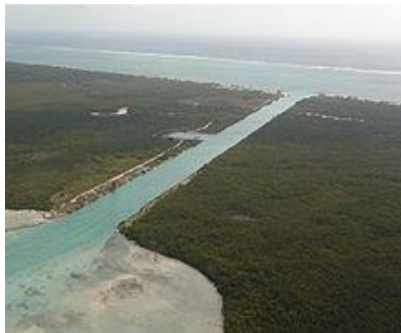
Figura 1.8.- Fotografía de la Vista aérea del canal de Zaragoza, comunica a la Bahía de Chetumal con el mar Caribe
