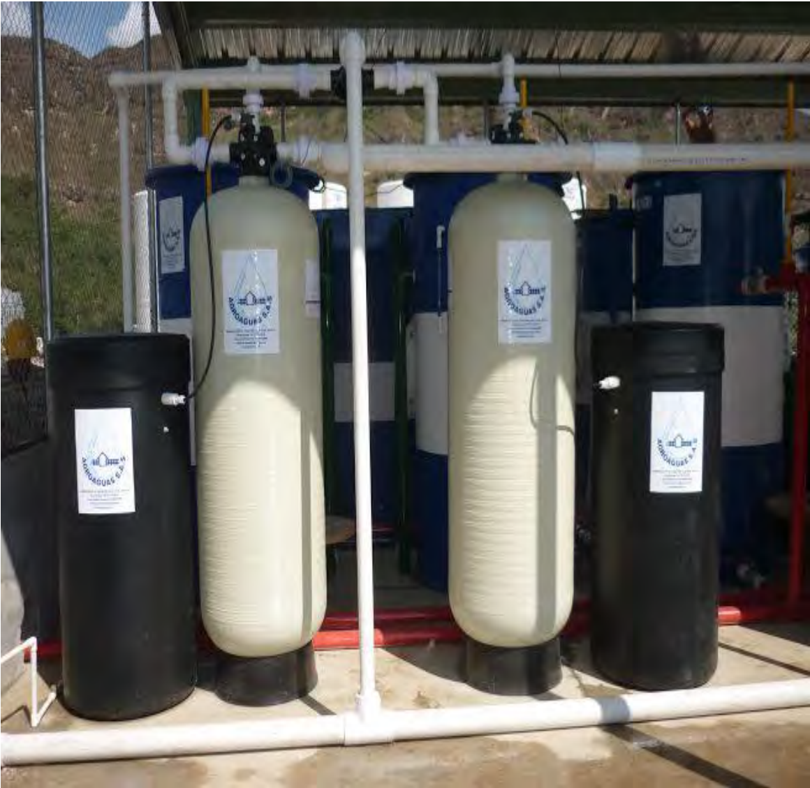
Figura No.10 Planta de intercambio iónico de dos lechos y dos salmueras
