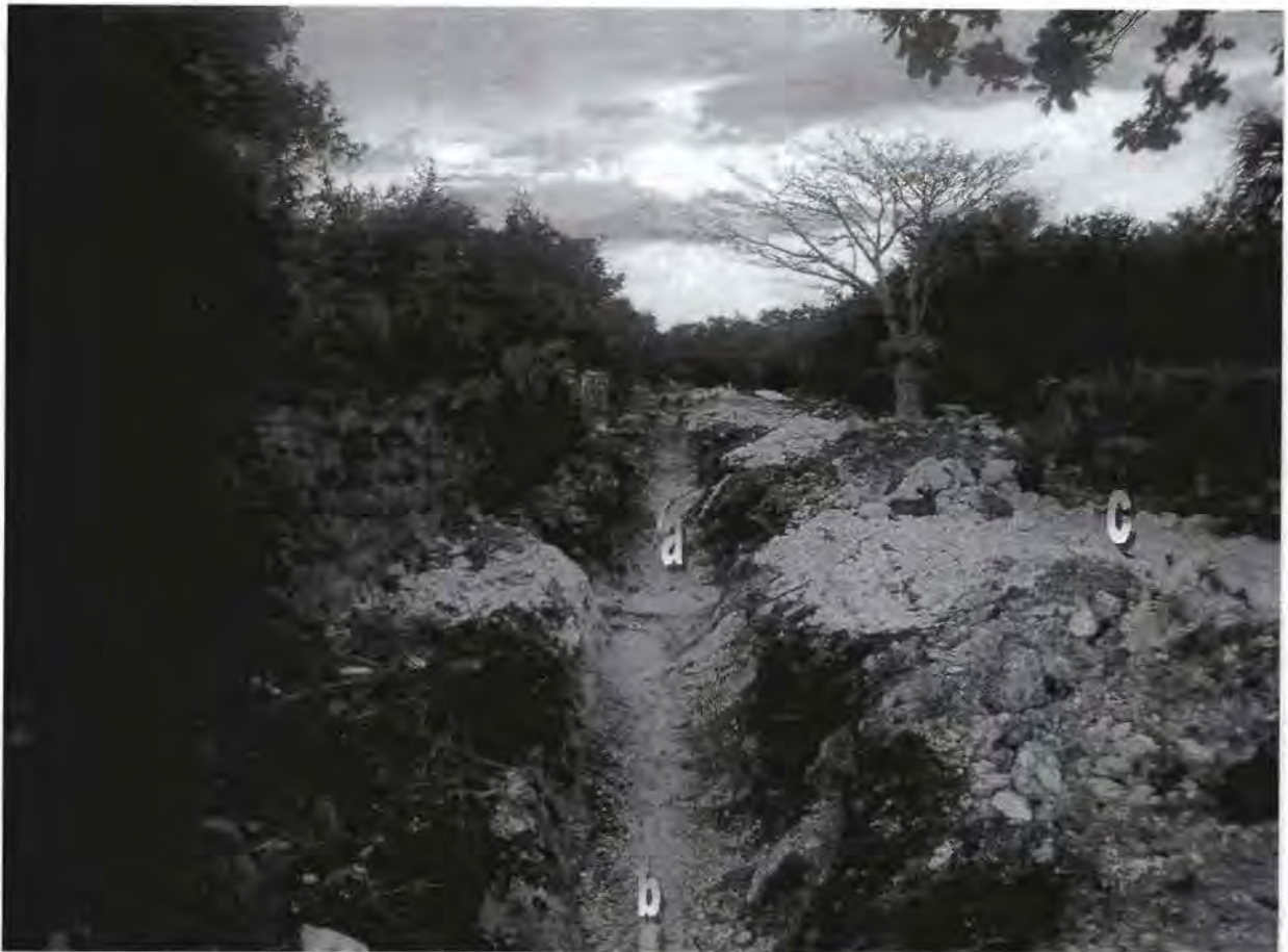
Figura 4. Excavación a mano del terreno; a) Excavación a mano de terreno tipo I y II; b) fondo y taludes sin afinar; c) material producto de excavación revuelto.
