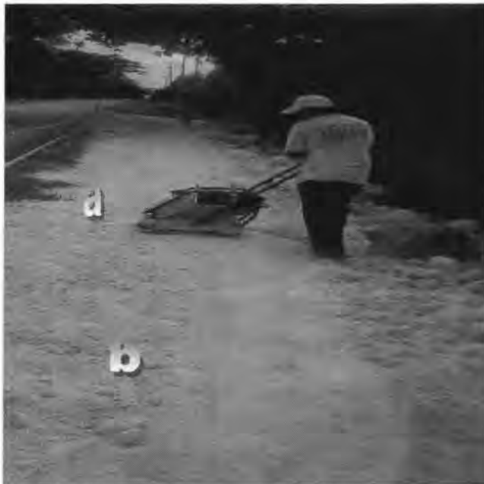
Figura 7. Compactación: a) Uso de placa vibratoria, b) Compactación de área de tránsito peatonal.
