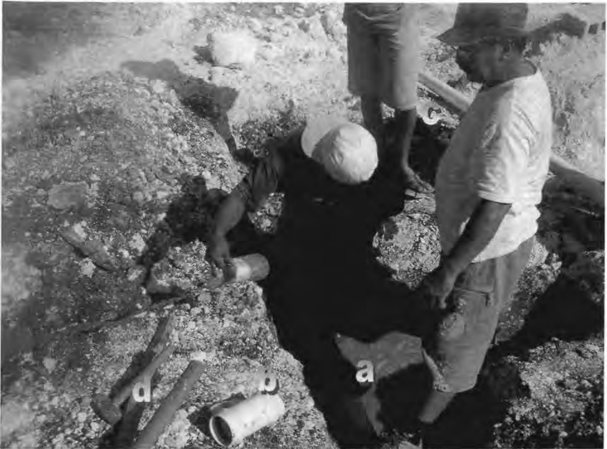
Figura 12. Reparación de tubería existente: a) Tubo de 3" seccionado, b) Cople corto de reparación, c) Tubería de reposición, d) Herramienta auxiliar de madera.
