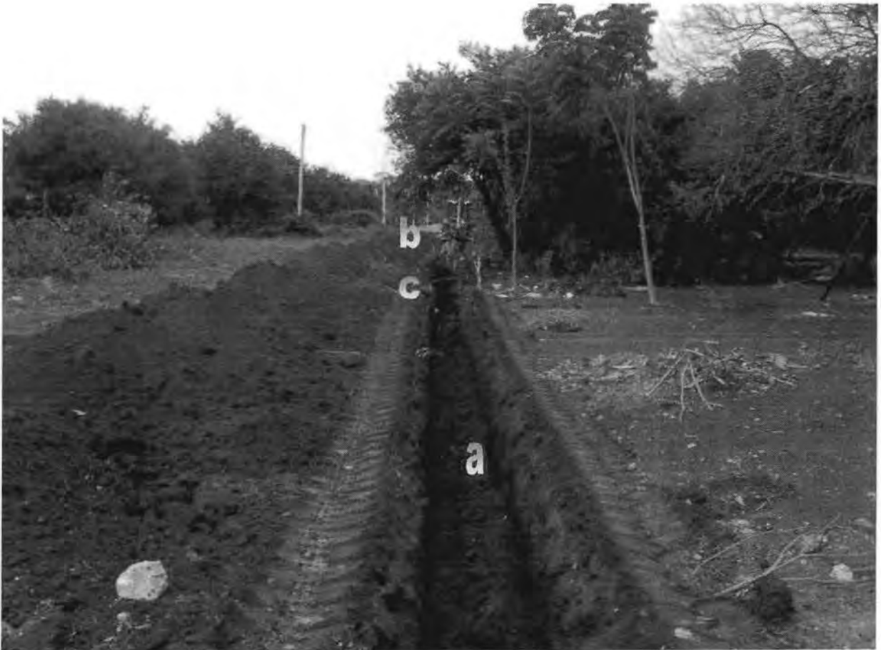
Figura 2. Excavación de zanjas: a) Excavación de zanja en material tipo I por medios mecánicos, b) Maquinaria en operación, c) Ayudante de operador.
