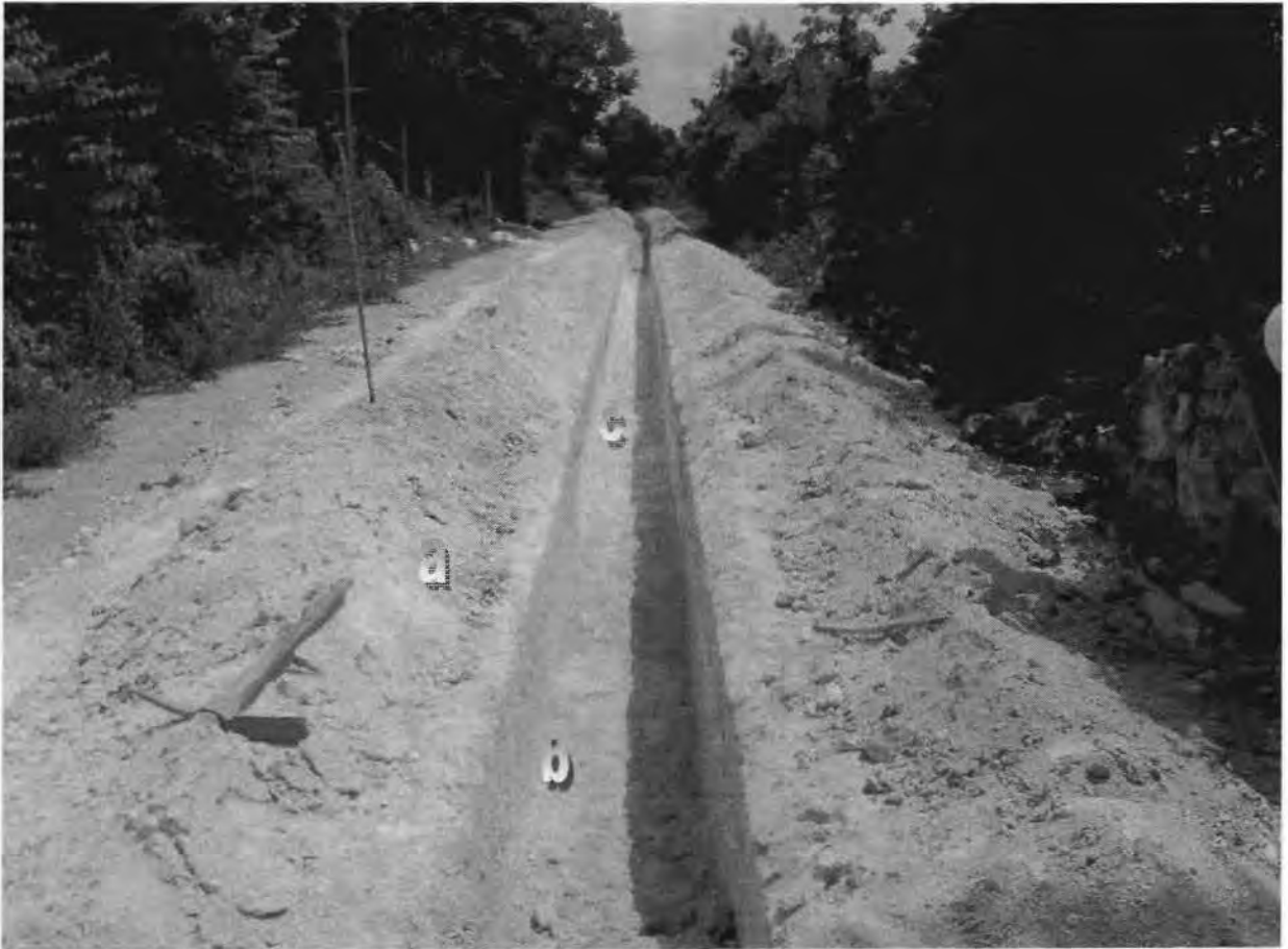
Figura 5. Afine de fondos y taludes: a) Material producto de excavación al lado de la cepa, b) Talud sin material suelto, c) Fondo libre de rocas o residuos de tamaño considerable.
