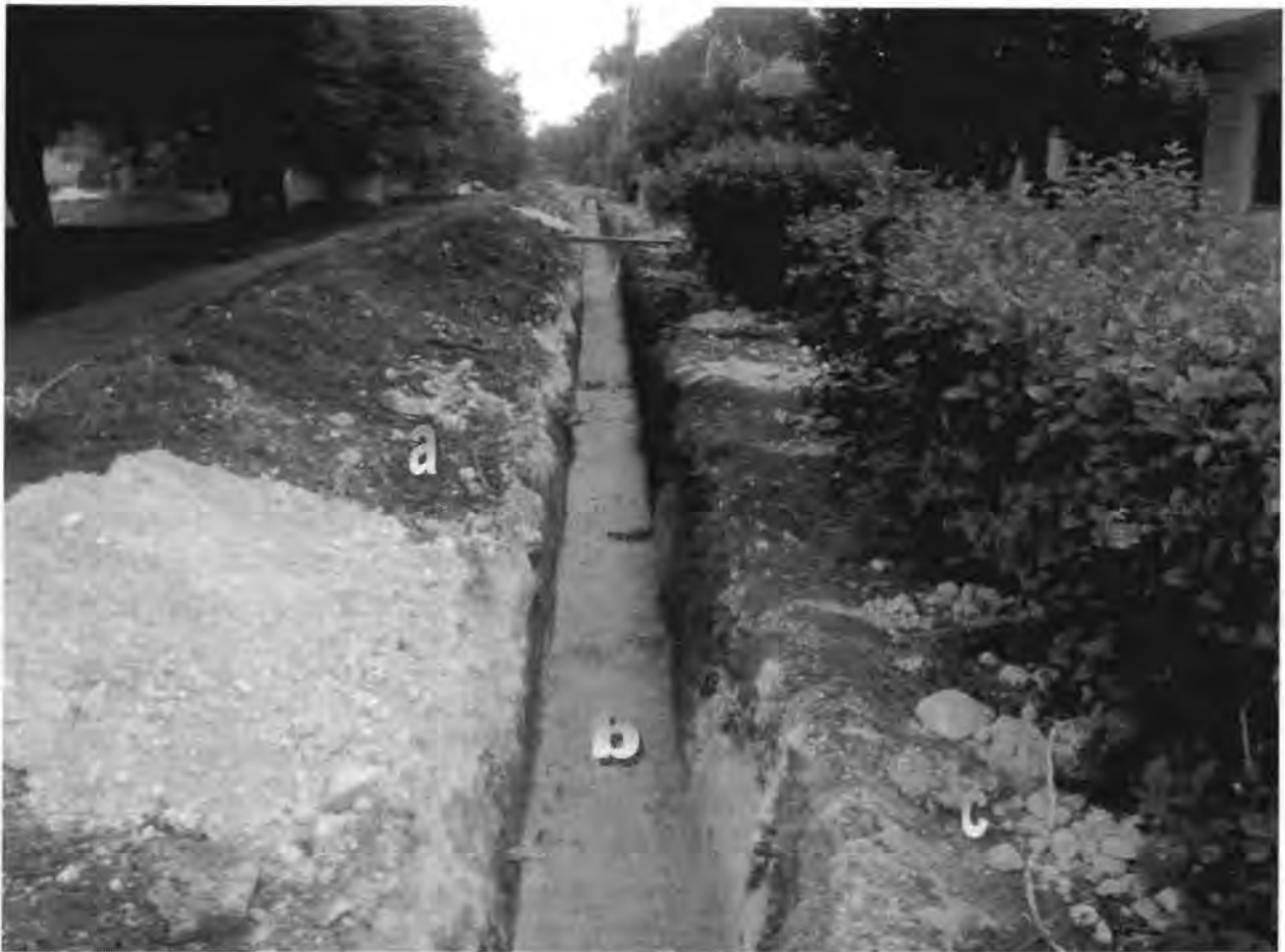
Figura 6. Elaboración de plantillas: a) Material producto de excavación al lado de la cepa, b) Afine de fondo con material producto de banco, c) Rocas separadas del relleno.
