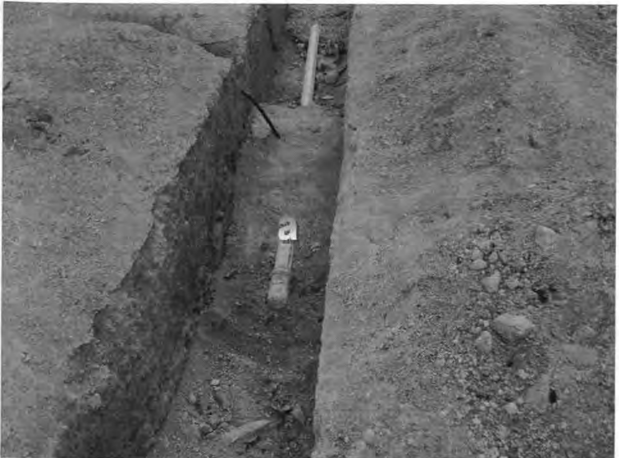
Figura 13. Colocación de tapón en tubería sin presión: a) Tapón tipo campana y anillo de hule.
