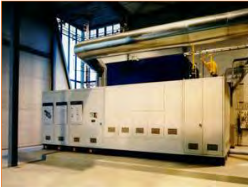
Figura 1.14- Fotografía de celda de combustible tipo desarrollada por Siemens Westinghouse de 100 kW (The Fuel Cell Way, 2006).
