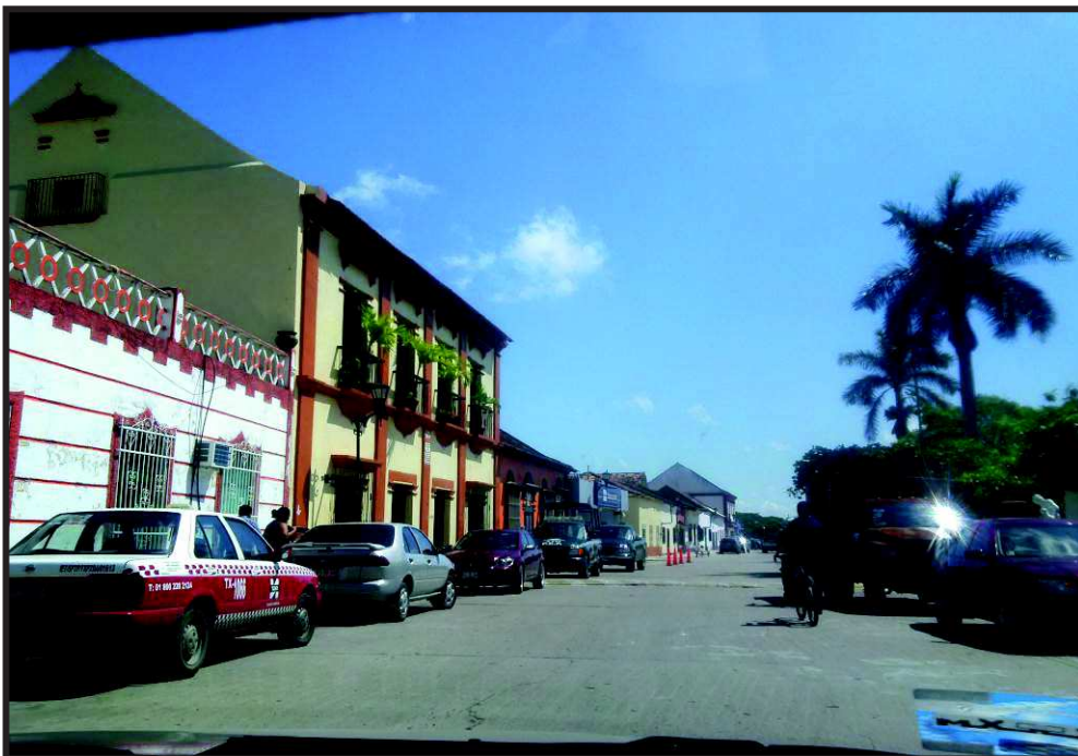
Fotografía 12: La arquitectura se caracteriza por sus casas construidas con techos de tejas francesas, Palizada, Campeche. Fuente: Dalila N. Gómez Vásquez, 18 de octubre de 2013
