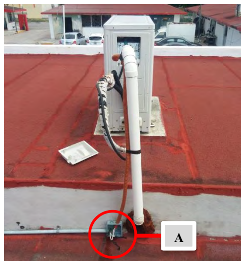
Figura 48 – Aire acondicionado en posición tal que impide ventilación para disipar el calor (Báez, 2014).
