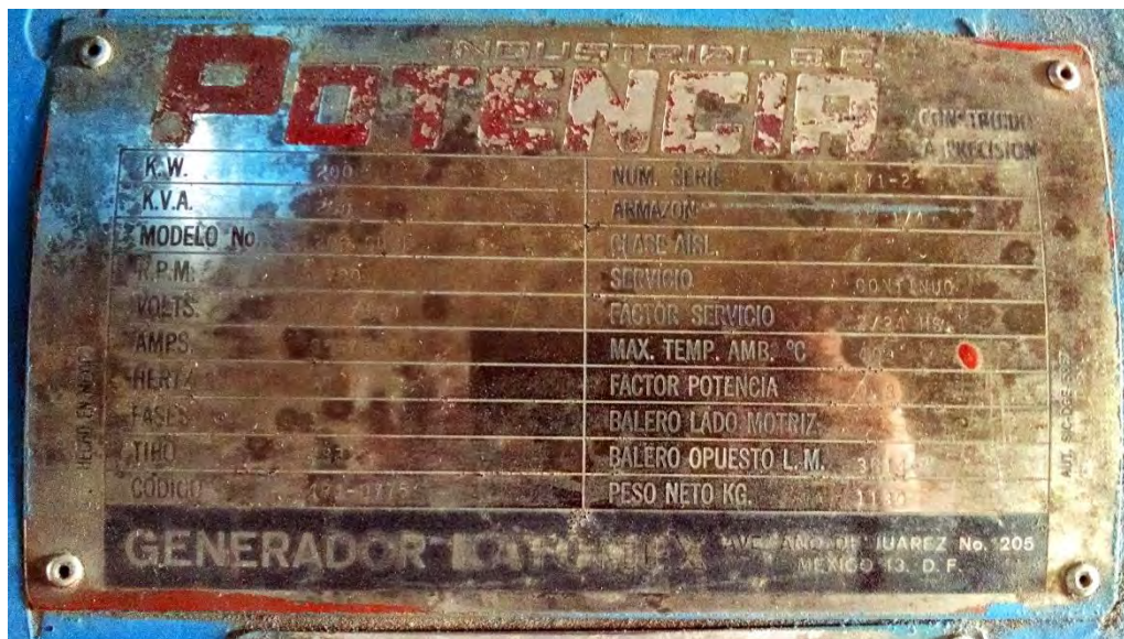
Figura 42 – Placa de datos de la planta de emergencia (Báez, 2014).
