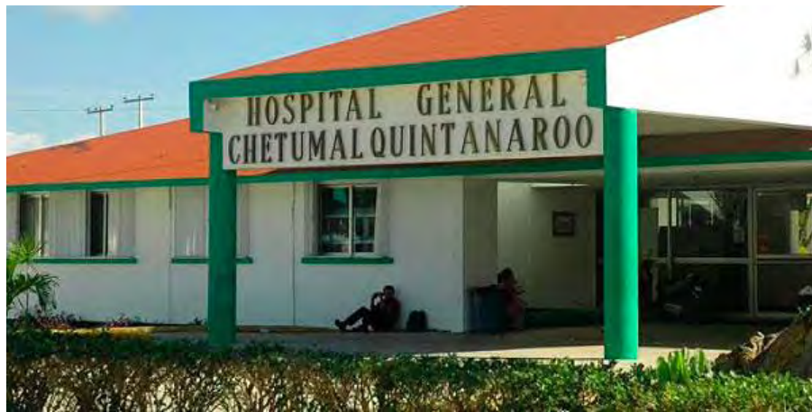
Figura 1 –Antigua fachada del Hospital General de la ciudad de Chetumal ( Gobierno del Estado de Quintana Roo, 2014 ).
