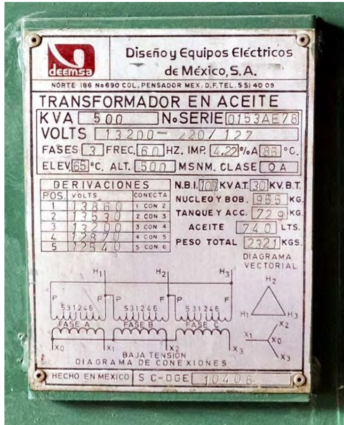
Figura 39 – Placa de datos del transformador principal (Góngora, 2014).
