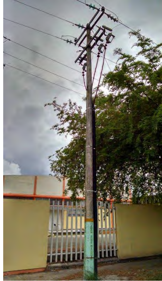
Figura 36 – Acometida desde el frente y la lateral ( Góngora, 2014 ).
