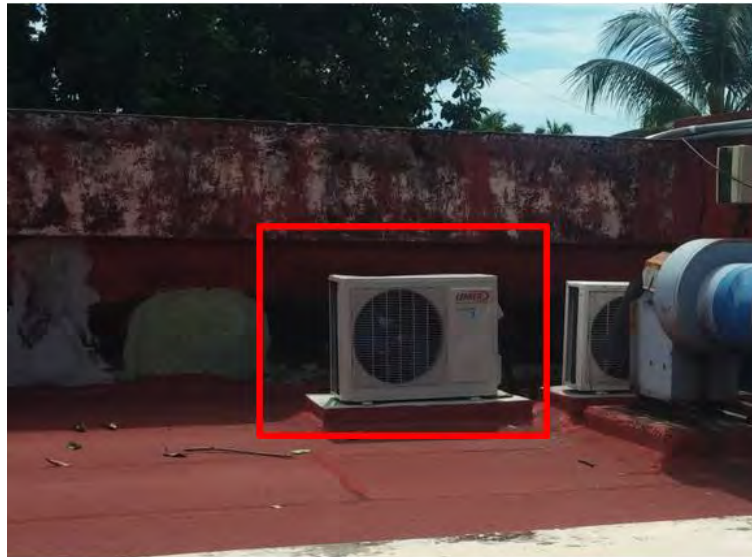
Figura 48 – Aire acondicionado en posición tal que impide ventilación para disipar el calor (Báez, 2014).
