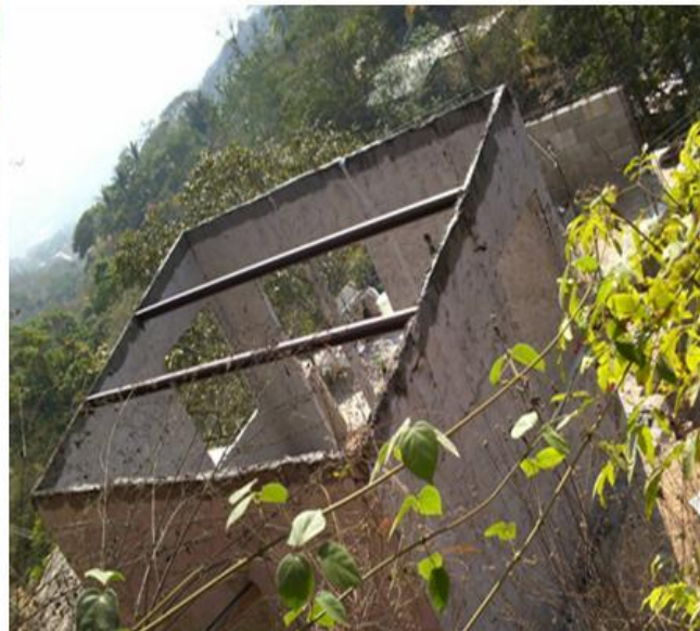
Elementos estructurales horizontales colados a la estructura de la vivienda
