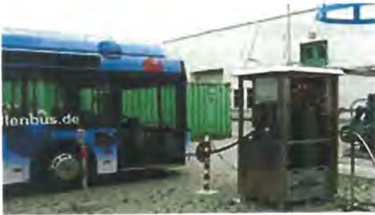
Figura 1.3.- Distribución de hidrógeno para Autobuses (Hidrogenera) por parte de Linde GAS.
