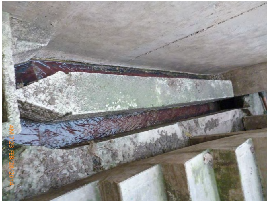
Figura 2.3. Canales de entrada agua residual al tanque de almacenamiento.
