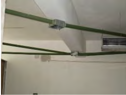
Figura 7. Distribución de tubería de 2"
