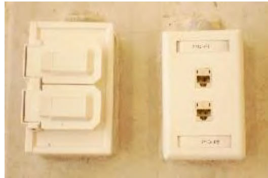
Figura 16. Salidas en muro, ya terminados.
