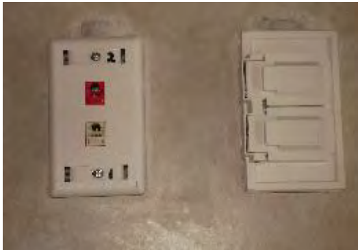
Figura 15. Salidas en muros de concreto.
