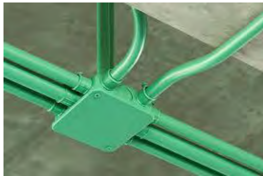
Figura 4. Ejemplo de distribución utilizando accesorios y tubería de pvc.
