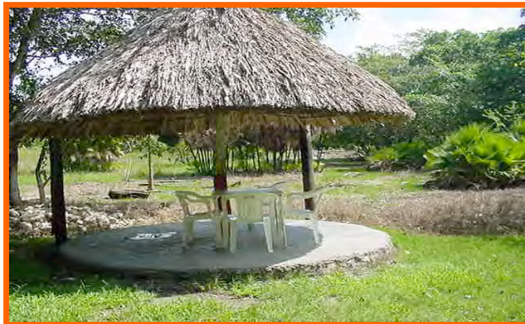
Figura 44. Restaurante Fuente: Propia
