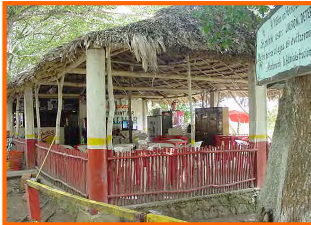
Figura 41. Restaurante Fuente: Propia
