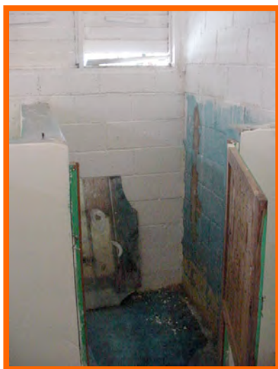
Figura 11. Cambiadores Fuente: Propia
