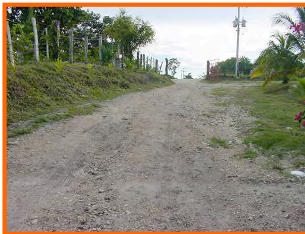
Figura 25. Calle Fuente: Propia
